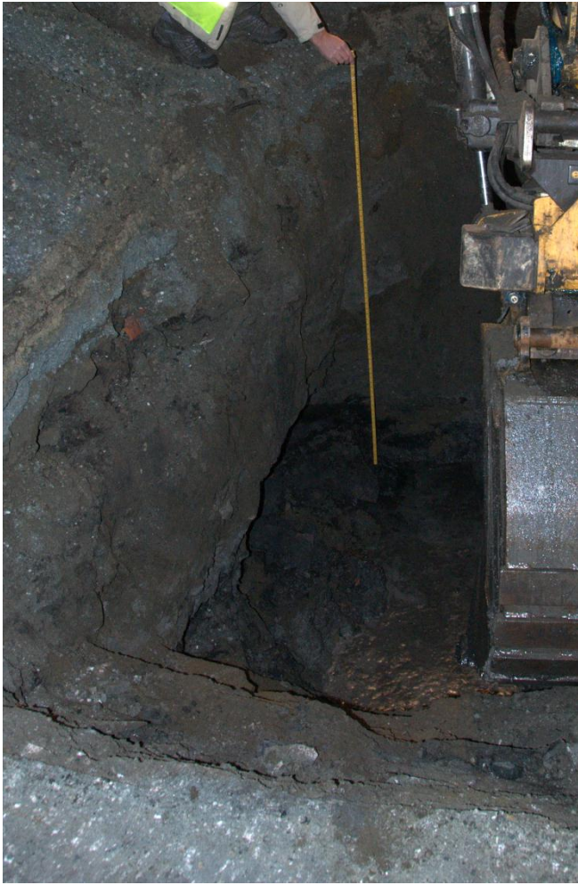
Prøvegrop 3. Dyp ca 3 meter. Avfallssjikt fra ca 2 meters dyp.
