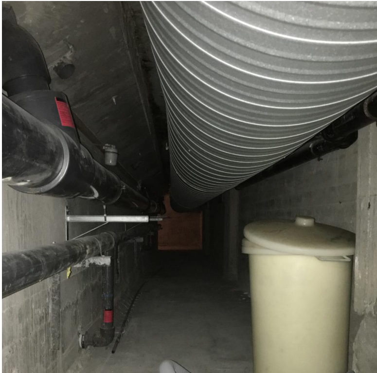
Bilde over - kulvert: Side 1 Orienteringsbilde (avtrekkskanal)
