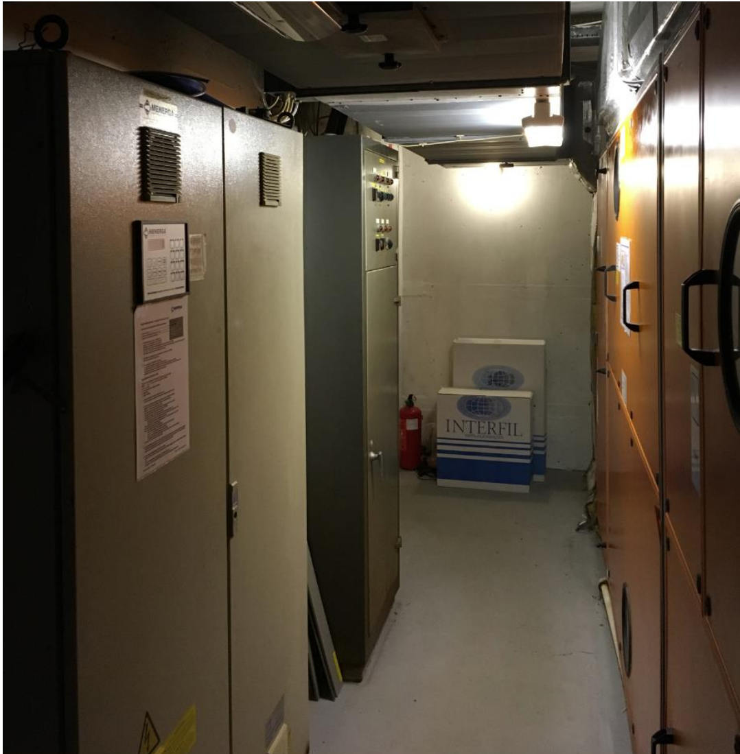
Bilde over – teknisk rom: Tavler styreskap som betjener aggregatet skal rives.
