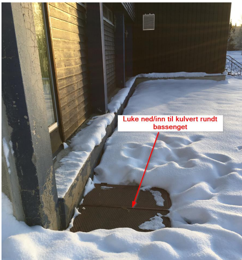
Bilde over – luke til kulvert – mulig føringsvei for kanaler
