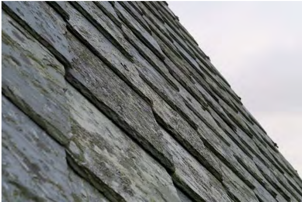
Her ses enkeltsteiner som er sekundært innfestet med spiker i synlig flate.
