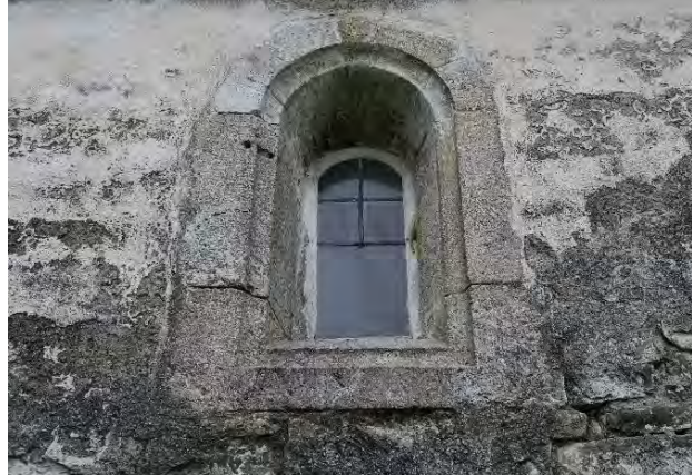
Opprinnelig vindusportal med klebersteinsomramning.
