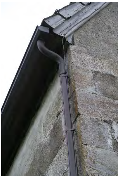
På gavlene er det ikke takutstikk, vindskier lagt rett mot muren.
