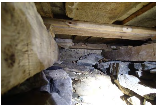
Langsgående bjelker sett mot øst.
