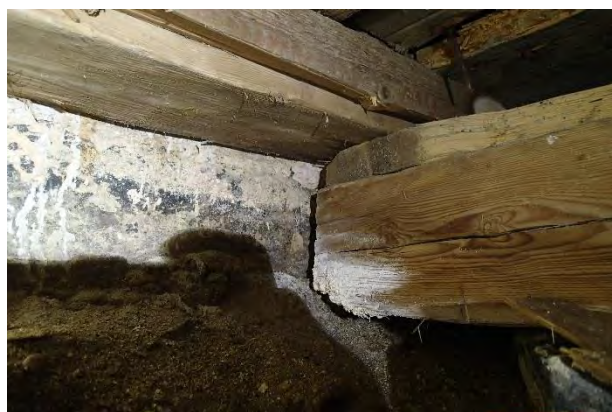
Detalj av bjelke mot øst, bjelken krager ut og ligger med litt klaring mot muren.
