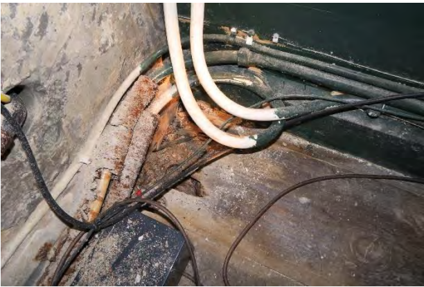
Gjennomgående råteskade i ytre del av gulvbord i skipets hjørne NV. Potensial for skjulte skader under.
