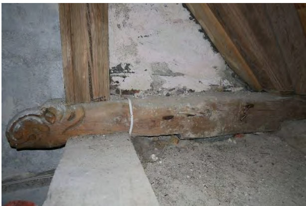
Stikksperre på murkrona, på murkrona i skipet sett mot korskillevæggen.
