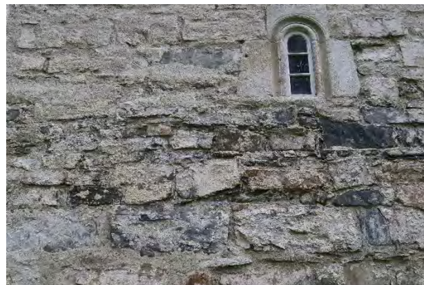
Det er bevart betydelige mengder gammel kalkpuss, som er herdet og sitter betydelig bedre til underlaget enn den nyere puss.
