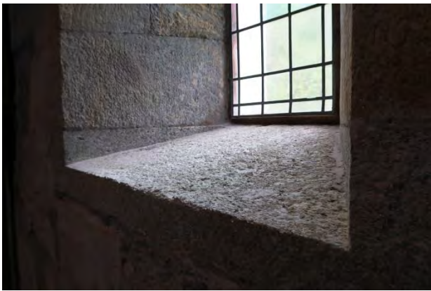
Vindu mot sør med presist utført klebersteinsomramning.
