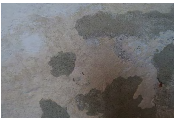
Hvit og gulaktig kalkhvitning med overliggende/grå flak av nedbrutt kalkslemming.
