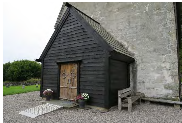
Våpenhus med støpt repos med skiferheller og løs rampe av strekkmotall. God stand.
