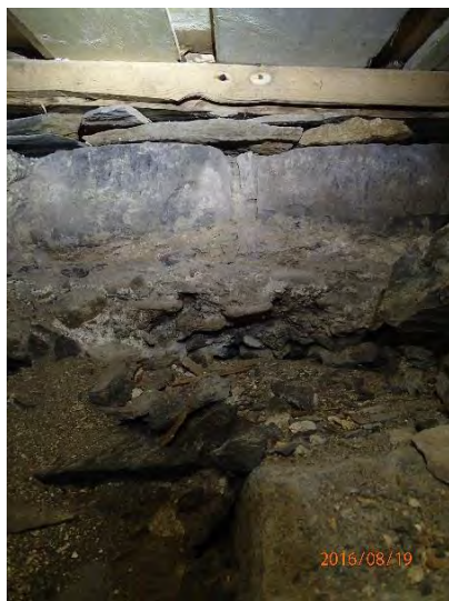
Spranget i kalkmurt nedre del av fundament er dels undergravet – dette antyder hvor terrenget trolig lå før utgravingen i 1912. Opprinnelig fundament er påforet med små tørrmurte steinheller.
