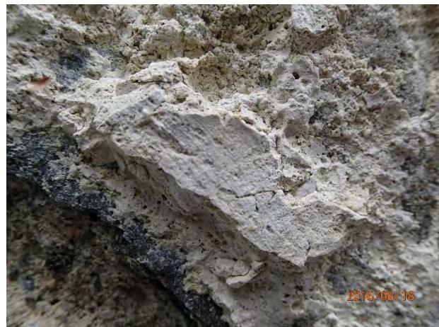
Detalj av bildet over. Her ses spor etter børste e.l. i pussoverflata.
