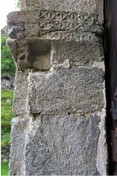
Venstre side av dørportal, spor etter ombygging av døra i 1868.
