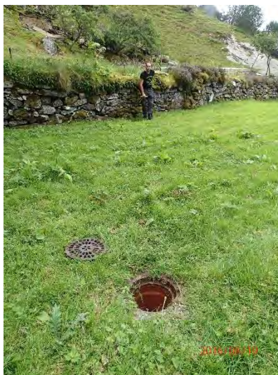
Kum sør for skipet. Ved muren i bakgrunnen er et bekkedrag med utløp i rør.
