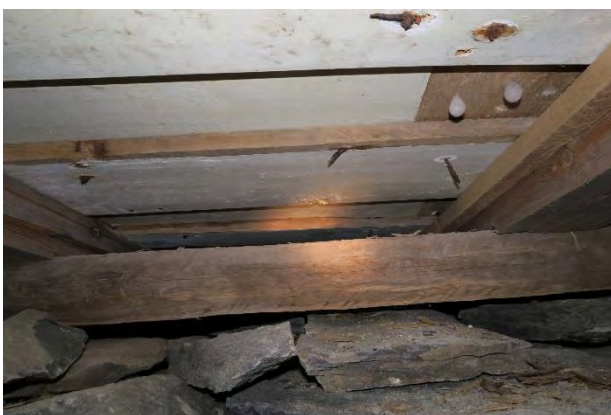
Bjelkelaget (gjenbruksmateriale med synlige øksehogg) ligger dels på holdstein hevet over murvekret. Tørrmurt fundament, antatt 1912.
