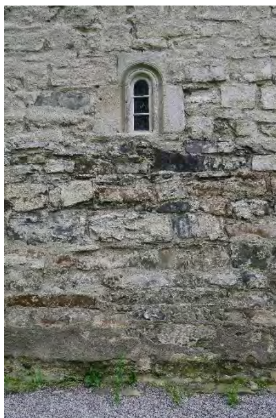
Typisk murverk av relativt små og uregelmessige steiner.
