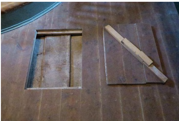
Luke ned til krypkjeller i koret, stubbloftsbordene må skyves til side. Ingen råteskader påvist i overgulvet.
