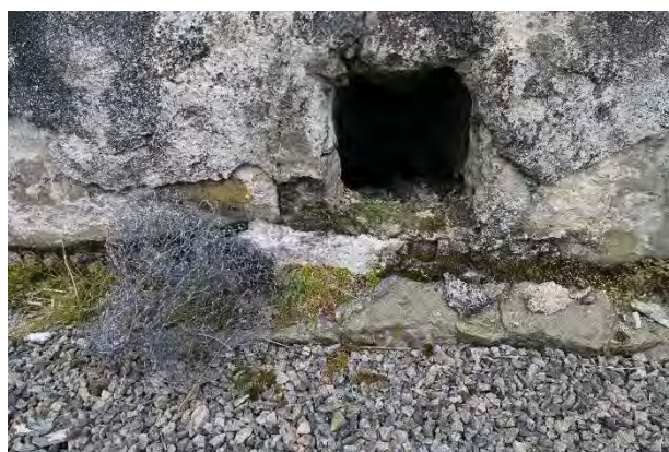
Skipets nordvegg. Typisk ventilasjonskanal til krypkjeller, fall innover. Ytre tetting av hønsenetting.
