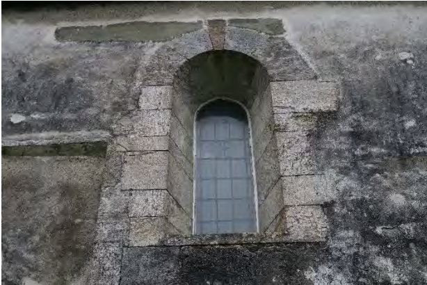
V1, skip N. Typisk vindu i skipet, blyspasseverk i indre ramme anno 1912, enkelt varevindu utenfor.
