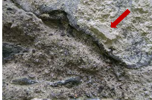
Eksempel på eldre kalkpuss med en liten bit som er bevart i full tykkelse, ca. 10 mm tykk.
