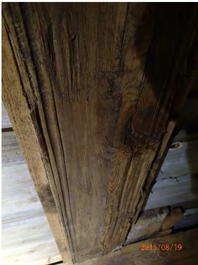
Typisk gjenbruksmaterial, boks med profil som er dratt med jern.
