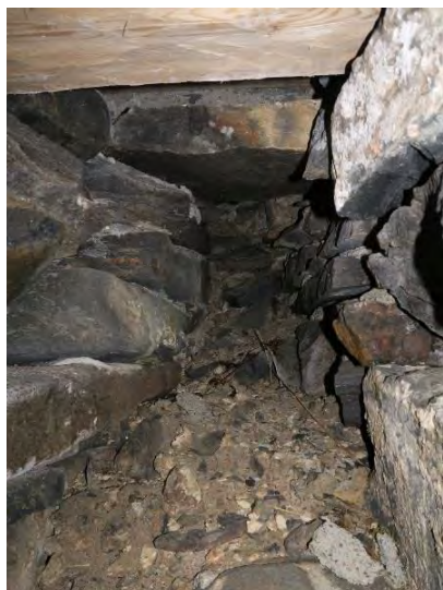
T.v. fundament for alteret. T.h. nyere tørrmurt fundament for gulv 1912. Sett mot endevegg i øst.
