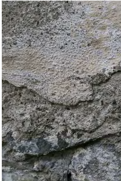
Små riss i pussen under vindu (ikke synlig på lite bilde). Rester av kalkvitning fra 1985 er bevart.
