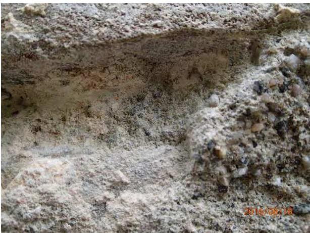
Eldre kalkmørtel i fuger, gulrosa tone og innslag av skjellsand, høy fasthet.
