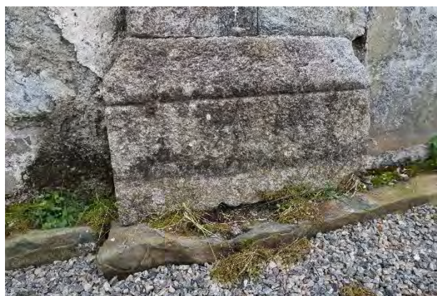
Sprang i veggliv i skipets nordvegg, frilagt sokkelstein med vegetasjon.
