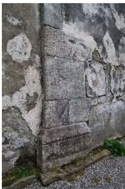
Detalj av kleberkvader/sokkel ved sprang i murlivet i skipets nordvegg.
