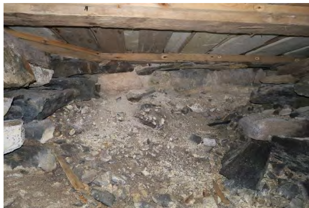
I enden av bildet ses fundamentet under korskilleveggen, med stein lagt i kalkmørtel. T.v. ses nyere tørrmurt fundament for gulvet lagt i 1912.
