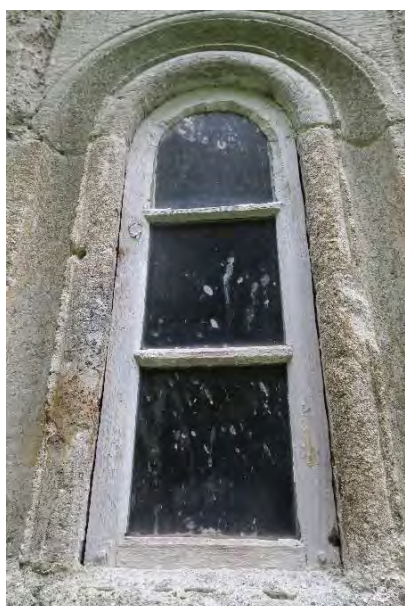
Vindu V3, kor Ø. Øvre rute har utvendig kitt, på de andre antas kittet å sitte på innsiden.
