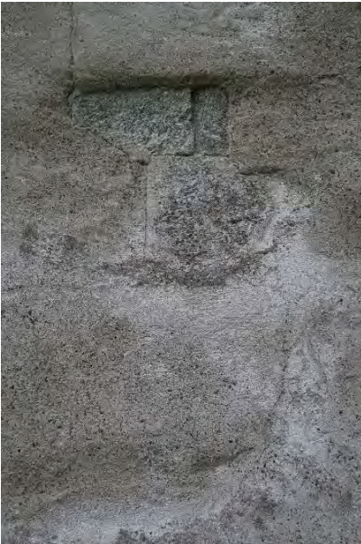
Detalj av veggparti, der pussen er avrundet inn mot et par eksponerte klebersteiner.
