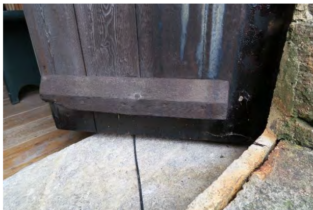
D1. Det er i senere tid montert utvendige dryppneser for å hindre vanninntrengning.
