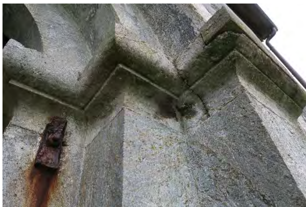
Detalj av bildet t.v., øverst t.h. ses en eldre reparasjon/spuns av stein.
