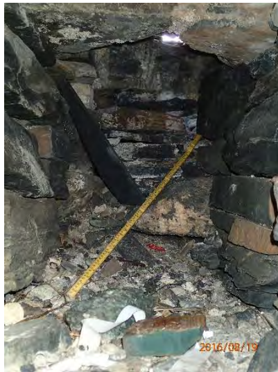
Ventilasjonsjakt mot nord, antas brutt ut 1912. Rester av kalkmørtel i overmuringen.
