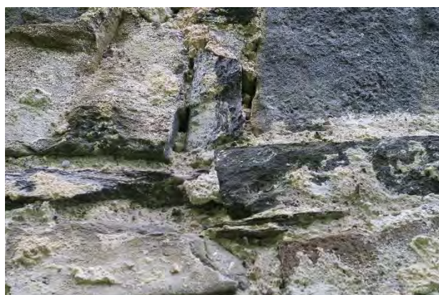
Felt med eldre murverk der pinningsteinen er komplett og eldre kalkmørtel bevart i fugene.
