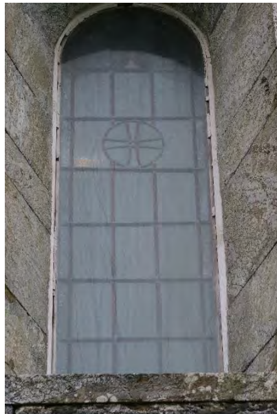
V1, skip N. Utvendige varevindu har betydelig kittutfall og nedbrutt overflate på treramme.
