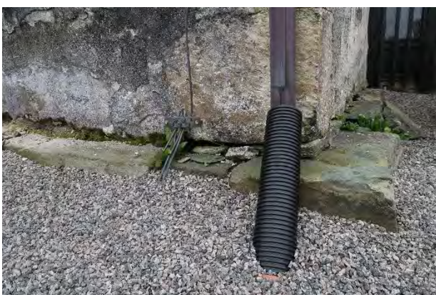
Hjørne NV, ny kobling fra nedløpsrør til drensledning, gruset drensgrøft. Synlig sokkelstein.
