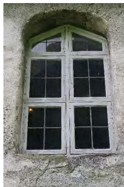
Vindu V4, kor S. Blyspasseverk med utvendig kittfals.
