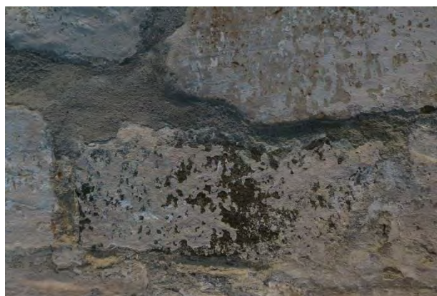
Det grå feltet er rester av en tynn kalkpuss/slemming, som har falt av over det meste av veggen. Under ses rester av hvit og varmtonet kalkhvitning direkte på steinen.
