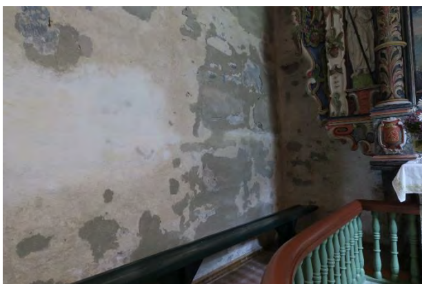
Utsnitt av nordvegg. Ulike valører av kalkhvitning og over dette rester av grå, tynn kalkslemming som ikke har tilfredsstillende fasthet, og faller av.
