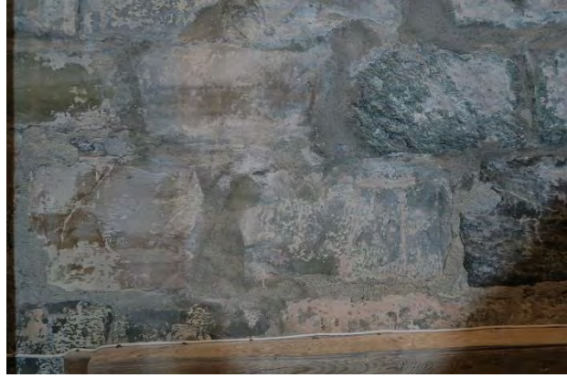
Sementfuger på sørvegg, øst for prekestolen. Rester av ulike valører kalkhvitning direkte på steinene.
