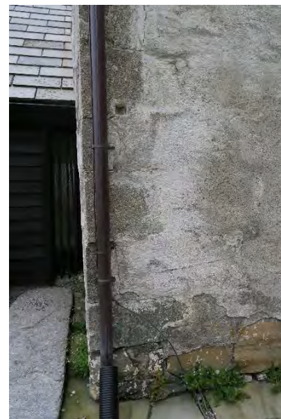
Hjørne SV, nedløpsrørene er dels innfestet i klebersteinen.
