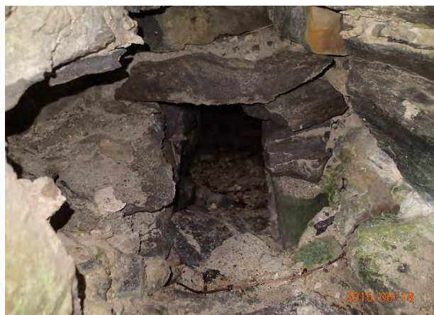
Inn i luftekanal, kanalen er trolig brutt ut senere (1912). Kalkmørtel i indre murverk.
