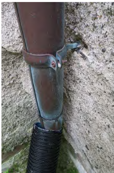
Innfesting i mur på korets sørvegg, overgang mot plastrør.
