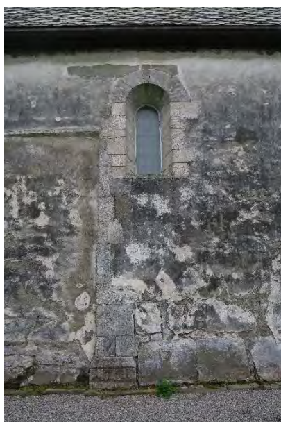
Detalj av vegg med sprang i murliv nær koret. Klebersteinsmarkering ved sprang og rundt vindu. Ved tilbakeføring av vindusåpningene i 1912 er deler av klebersteinsbuen fornyet (ses som mørkere stein i toppen).
