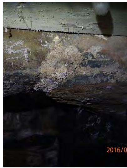
Detalj av bildet t.v., med eldre kalkmørtel i fuge i overmuringen.
