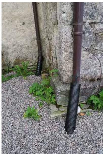
Kortvegg i overgang kor/skip mot nord/øst.
