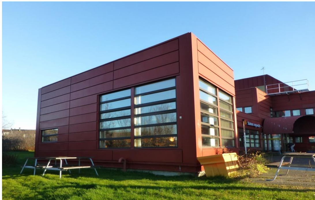
Bilde 9 Fasade av vestre og søndre hjørne tilbygg vest.
