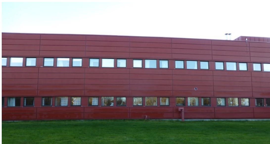
Bilde 6 Fasade vest – nord for tilbygg.
