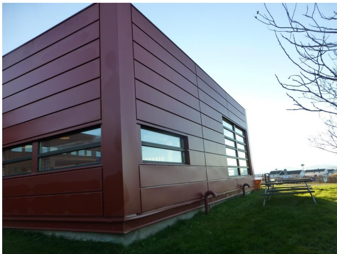
Bilde 8 Fasade Nordre hjørne av tilbygg vest.
