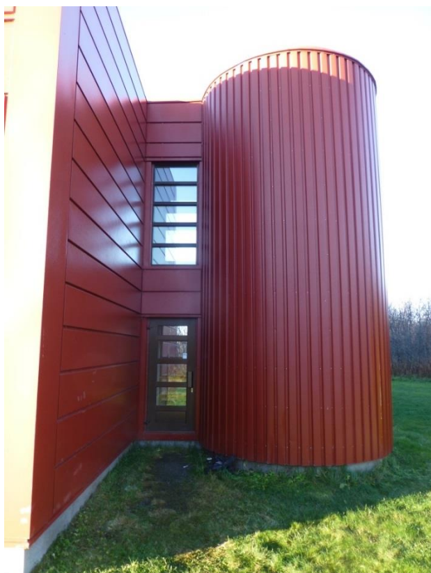
Bilde 4 Fasade Øst – Nord - trapperom
