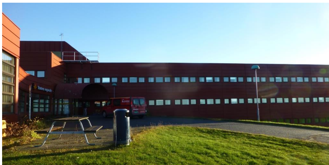
Bilde 10 Fasade vest syd for tilbygg vest.
