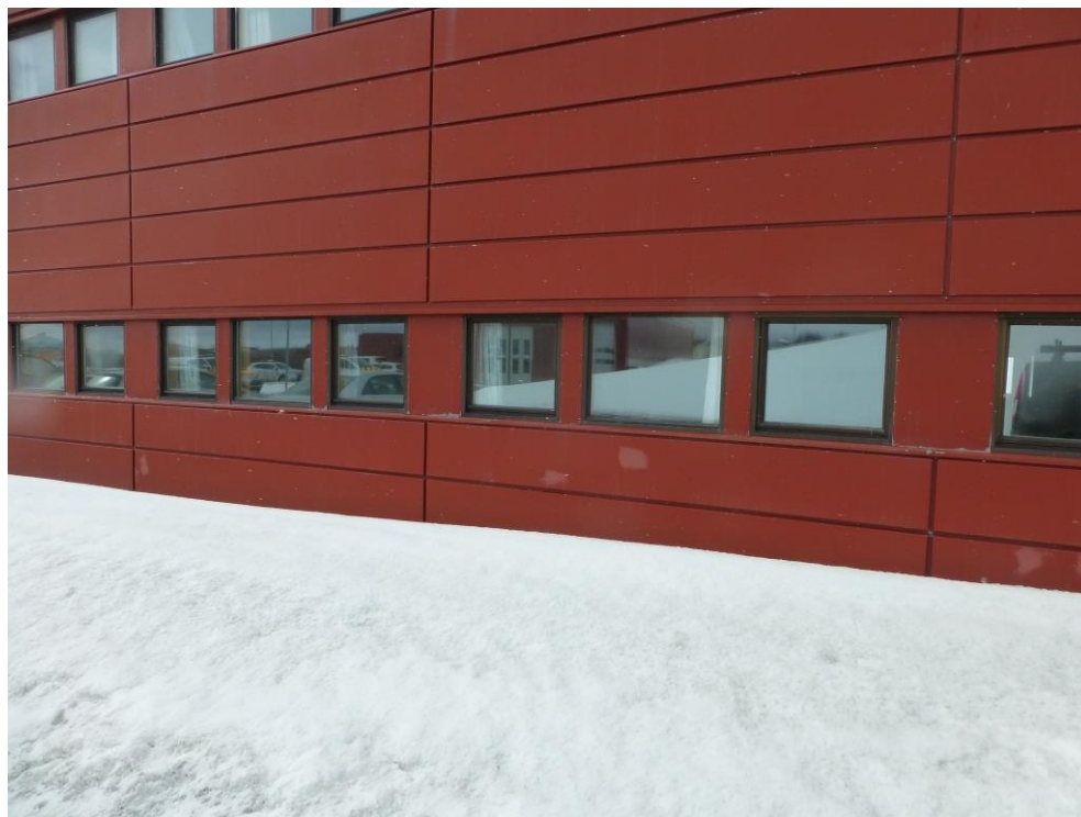
Bilde 13 Vindusbånd fra Østfasade
