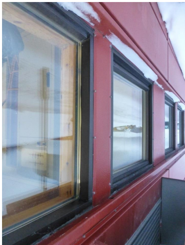
Bilde 14 Detalj fra vinduer
