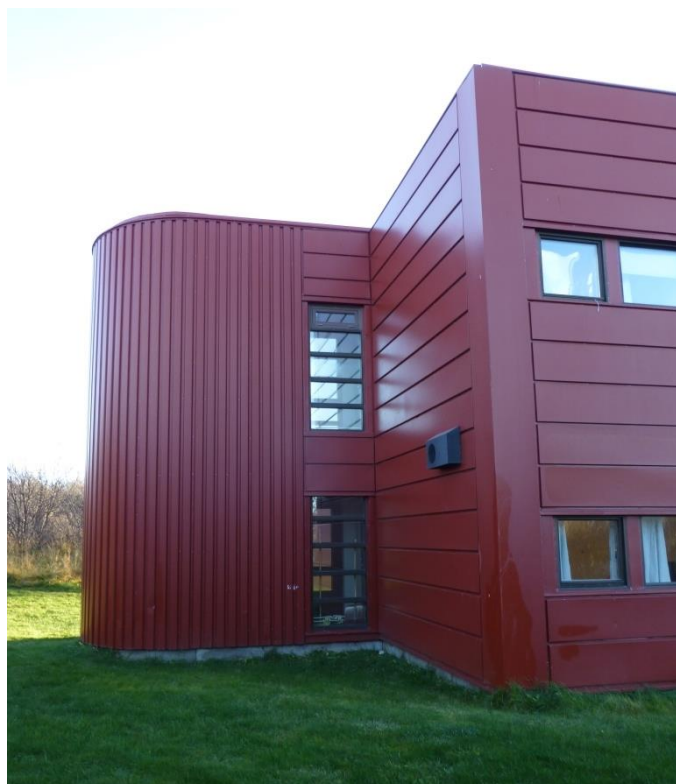
Bilde 5 Fasade Vest - trapperom nord.
