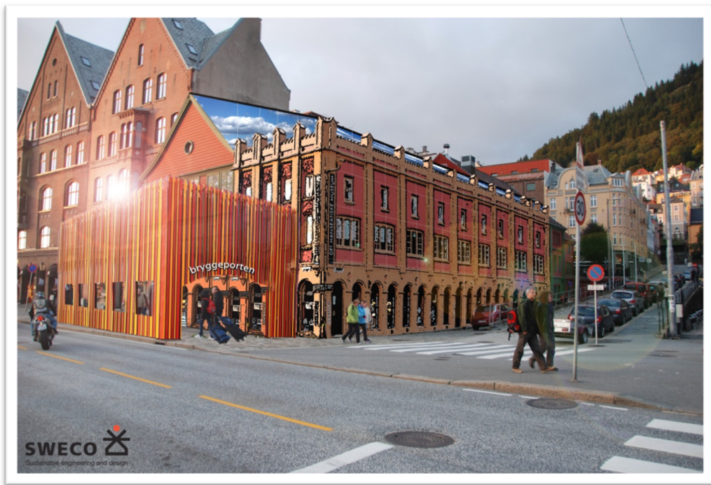
Figur 7, Illustrasjon over riggområdet med tak over tak og stillas kled med "bilde" av Det hanseatiske Museum (Illustrasjon laget av Daniel Tabaracu, Sweco Bergen.)
