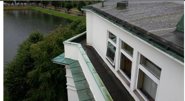
110 Hovedtak, takrenne med firkantet utførelse, rennekroker og «underbeslag». Kopperbeslag på gesims 1 på parapet. Kopperbeslag på gesims 2.
