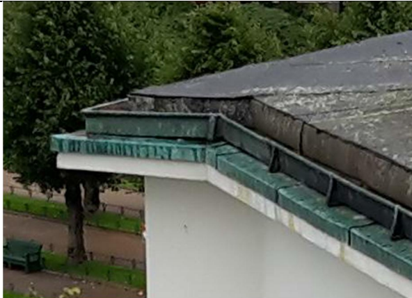
109 Hovedtak, takrenne med firkantet utførelse, rennekroker og «underbeslag»
