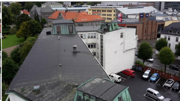
104 Takoppbygg 1, 2 og 3. Takhatter og inntekkinger.
