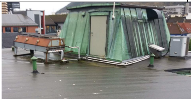
103 Oppbrett innunder NY båndteking på fasade takoppbygg 2.
