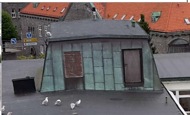
102 Oppbrett innunder NY båndteking på fasade takoppbygg 2.
