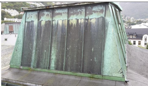
101 Oppbrett innunder NY båndteking på fasade takoppbygg 1.
