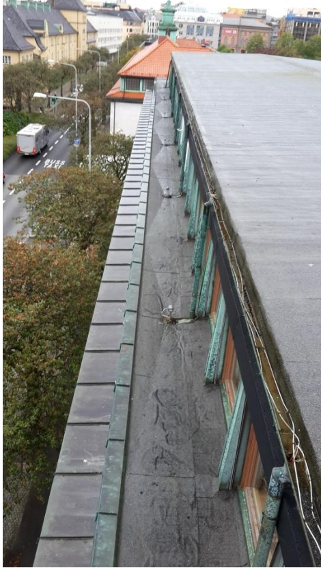
21 Øverste gesims, gesims 1 og gesims 2. Fasade i 4. etasje.
