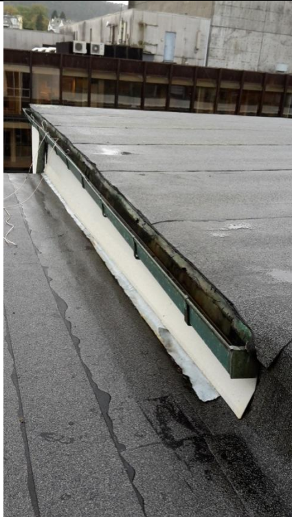
15 Takoppbygg 1, med 2 stk. beslag inn mot «vegg». Et overliggende og et underliggende.
