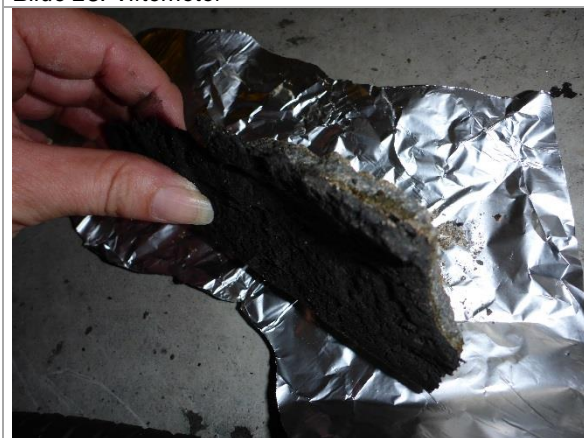
Bilde 30: Oljeforurensning (lavforurensning) i betong
