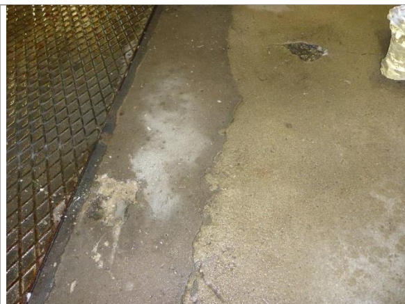
Bilde 13: Betong i vaskehallgulv, ren for PCB.
