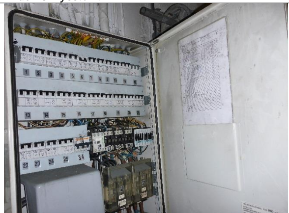
Bilde 45: Sikringsskap
