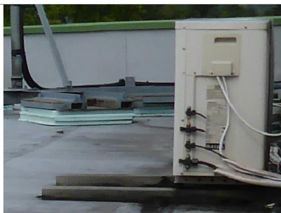
Bilde 24: Impregnert trevirke på tak
