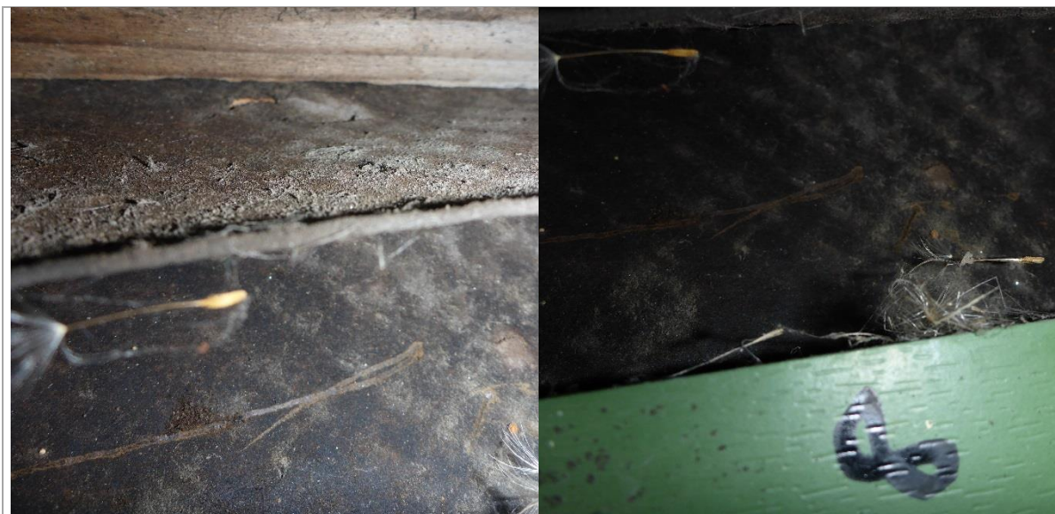
Bilde 1: Vindsperre i yttervegg
