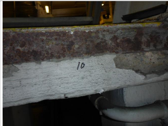
Bilde 9: Hvitmaling på verkstedvegg, lavforurensset av PCB.
