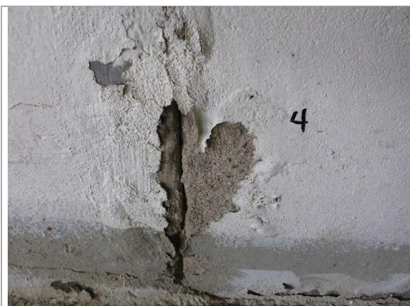
Bilde 5: Hvitmaling på bussgarasjevegg, lavforurenset av PCB.
