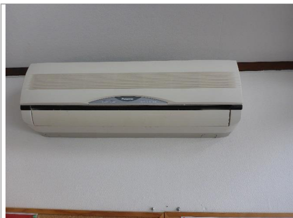
Bilde 32: Varmepumpe
