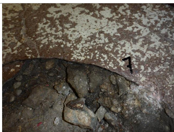
Bilde 8: Betonggulv i bussgarasje, rent for PCB.
