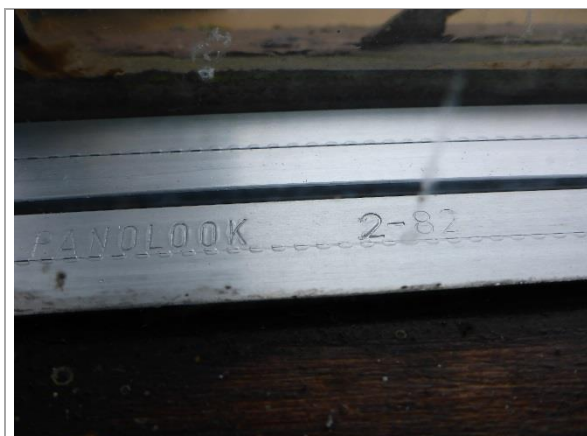
Bilde 15: Isolerglass fra 1982
