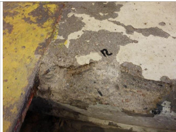
Bilde 11: Betong i verkstedgulv, ren for PCB.
