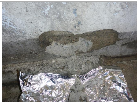
Bilde 14: Murpuss på vegg i vaskehall, ren for PCB.
