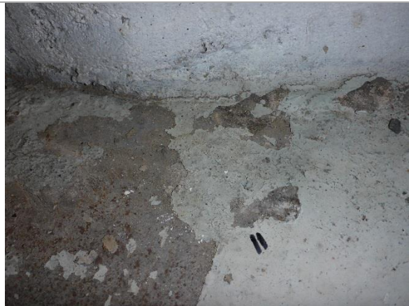
Bilde 10: Epoxybelegg på verkstedgulv, rent for PCB.
