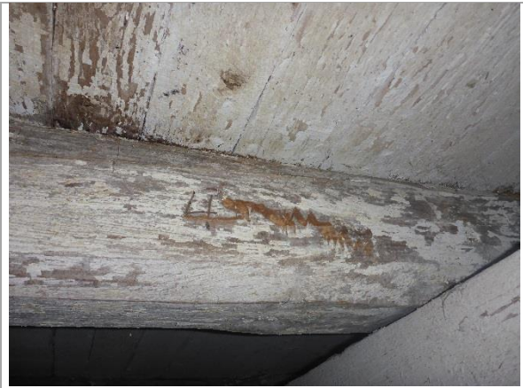
Bilde 4: Hvitmaling innvendig
