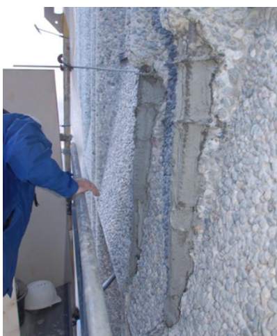
Bilde 7 Bildet viser at det er boret inn nye bøyer og det er ilagt første lag med reparasjonsmørtel.
