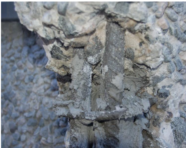
Bilde 8 Viser hvordan nye bøyler er montert og første lag med reparasjonsmørtel er lagt. En ser luftlommer i reparasjonsmørtel. Det er viktig at reparasjonsmørtel omslutter armeringen. Slike hulrom skal ikke forekomme. Bildet viser også hvordan overflatene skal være mellom påkastene.
