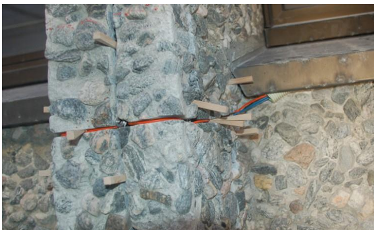
Bilde 14 Bildet viser orange tillederkabel til de 3 sagtann anodene. Tillederkabelen, en \varnothing 1,2\text{mm} isolert titantråd, legges i skårne spor i betongoverflaten. Sammenføyningen mellom anode og titantråd er en mekanisk forbindelse laget i titan der en teiter i mutter som presser tråden mot sagtann anoden. NB En må huske at forbindelser og tilledertråder fungerer som anoder. Disse må enten isoleres fullstendig eller lages av et inert materiale. (Stål, kobber, aluminium o.l. må ikke benyttes) Bildet viser også at det ble innlagt et plast, trekkerør inn under beslaget for vinduene for fremlegging av kabler. Røret må festes til betongen.
