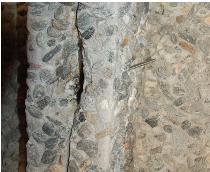
Bilde 12 Armeringsforbindelse. For å få tilførselskabel til armeringsforbindelse inn i hjørne mellom søyle og brystning, ble det boret et skrått hull fra forkant søyle, litt til siden av en bøyle og skrått inn mot innerhjørne. Gjengestag ble så stukket gjennom hullet og sveiset til bøylene i forkant søyle. Deretter kuttet gjengestaget og kabel festes til gjengestag med kabelsko. Kable kan så legges i skrått spor inne i hjørne.
