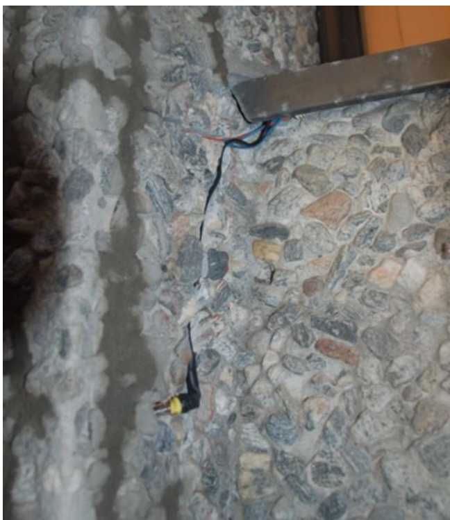
Bildet 13 Viser kabelsko beskyttet med krympestrømpe med lim før i støping for å skjule armeringsforbindelsen.
