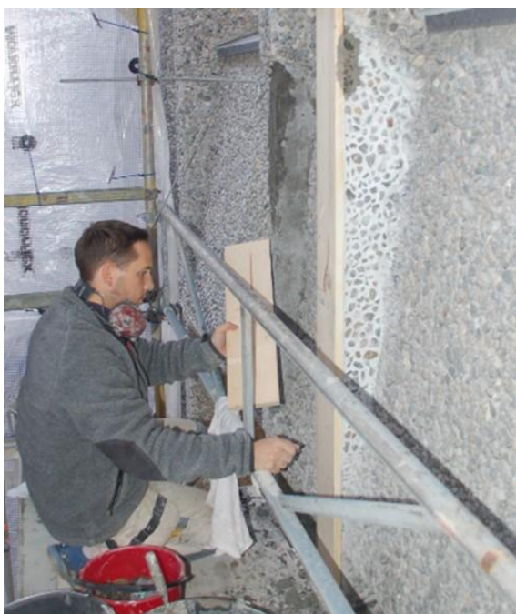
Bilde 9 Bildet viser oppbygging av nye overflate ved første forsøk. Forskaling mot eksisterende overflate vil bli flukte med denne overflaten. Forskalingen langs ytterkant av søyle kan brukes som rettesnor for reparasjoner på sidene og for ilegging av overflatestein på sidene. Når forskalingen ytterst fjernes, må en fjerne mørtel langs hjørnene slik at en kan legge inn mørtel i forkant og sette inn stein. Steinene skal så flukte med eksisterende overflate.
