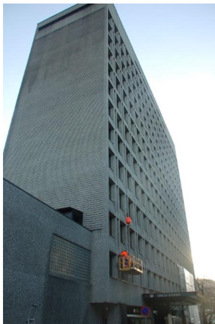
Bilde 1 Bilde viser nordfasaden
