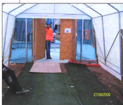
Adkomst til bygningen er tilrettelagt med sluse og matter
