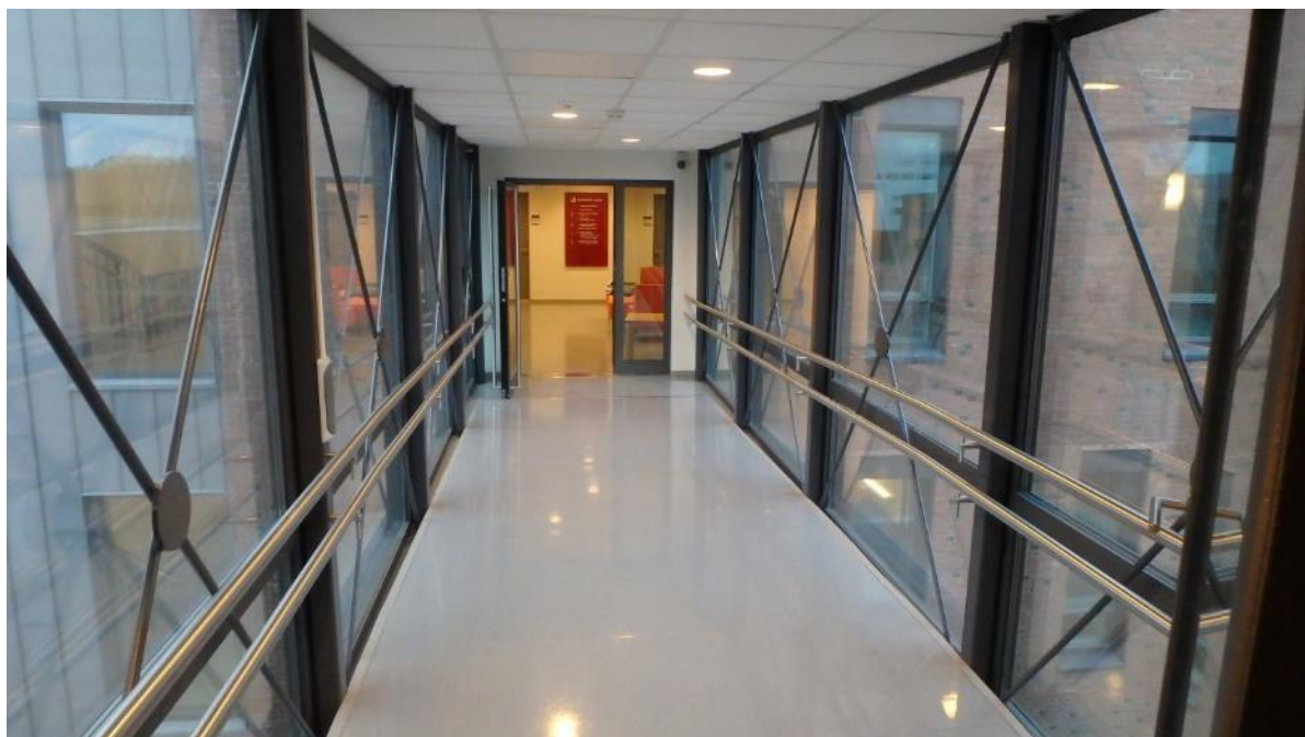
Gangbro mellom bygg G og K innvendig
