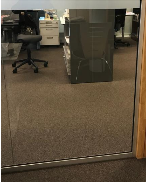
Eksempel på utførelse profiler i glassvegger
