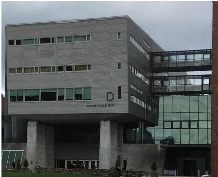
Gangbro mellom bygg A og D sett utenfra
