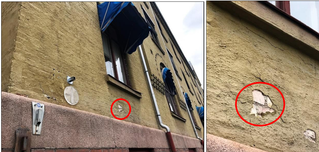
Figur 1: Fasade mot Slemdalsveien, hvor prøve 1 av maling/murpuss ble utført.
