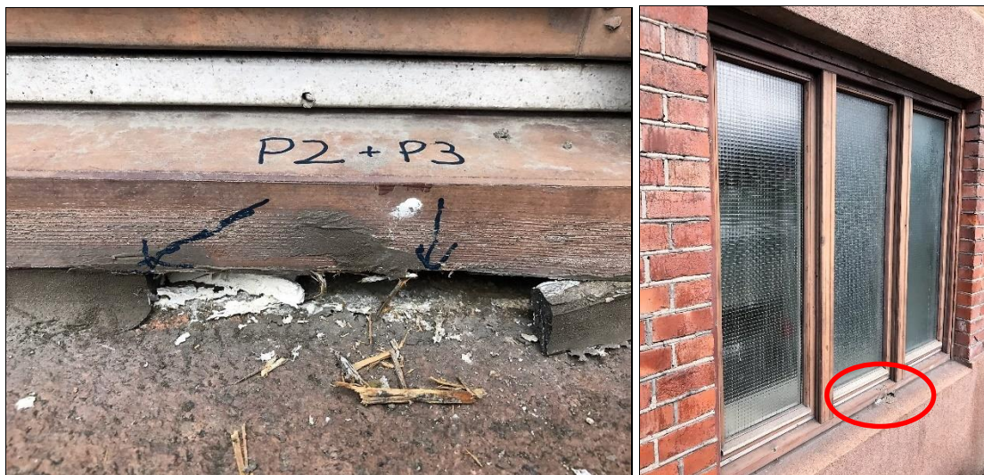
Figur 2: Fasade mot Slemdalsveien, hvor prøve 2 og 3 av grå og hvite fuger ble utført.
