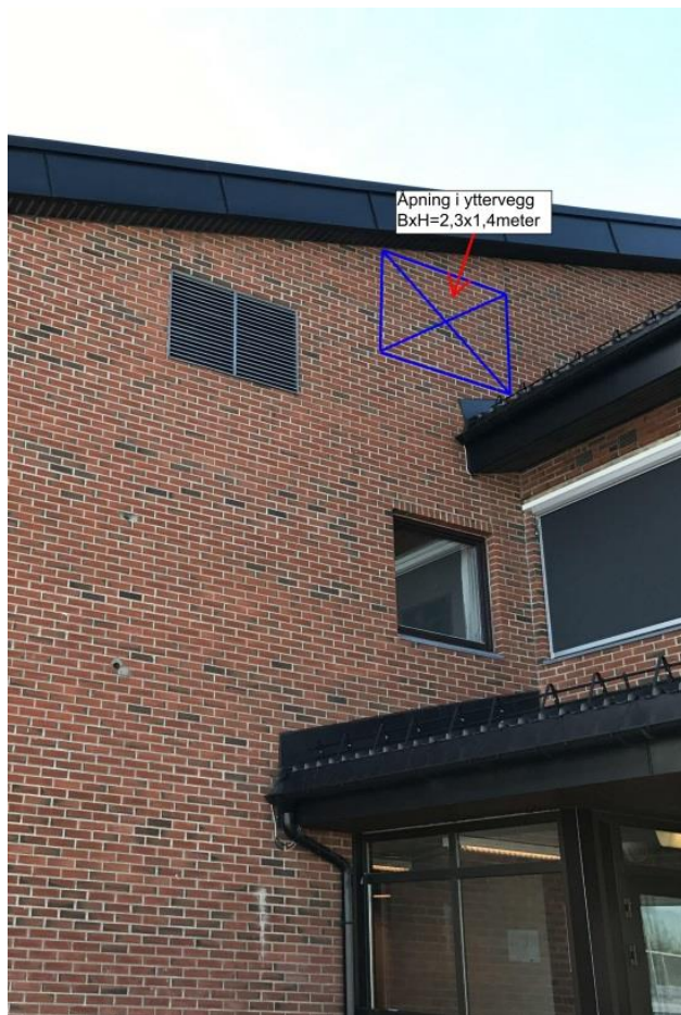
Fig. 6.1 - Åpning i yttervegg
