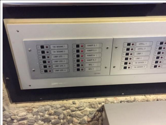
Bilde nr. 5.06 Lysstyringstablå
