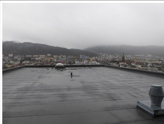
Bilde nr. 2.23 Yttertak
