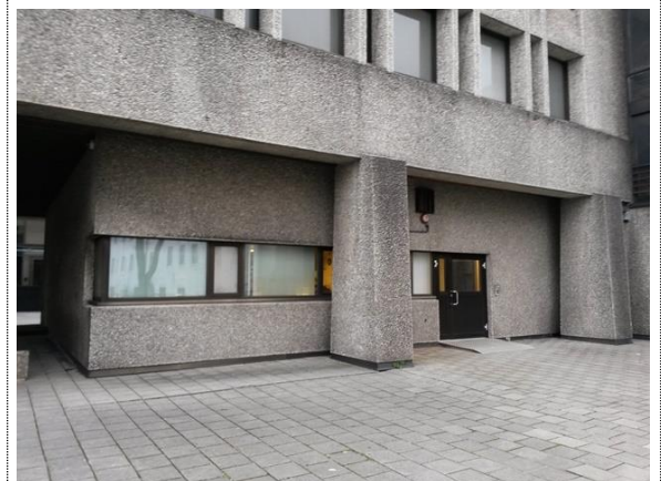
Bilde nr. 2.04 Fasade mot sørøst
