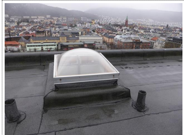
Bilde nr. 2.24 Yttertak, med gjennomføringer
