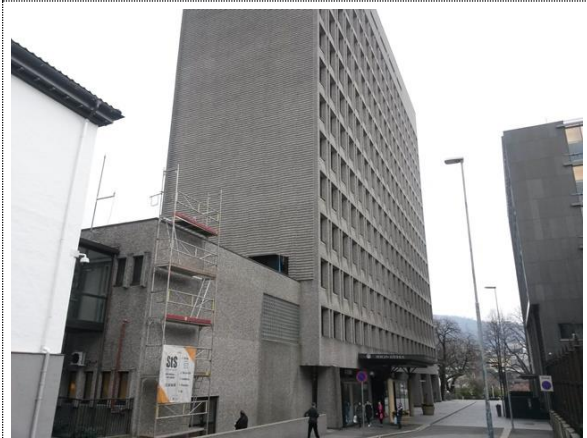
Bilde nr. 2.01 Fasade mot nordvest
