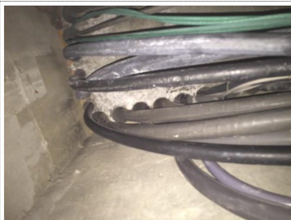
Bilde nr. 4.07 Stigesjakt fra kjeller
