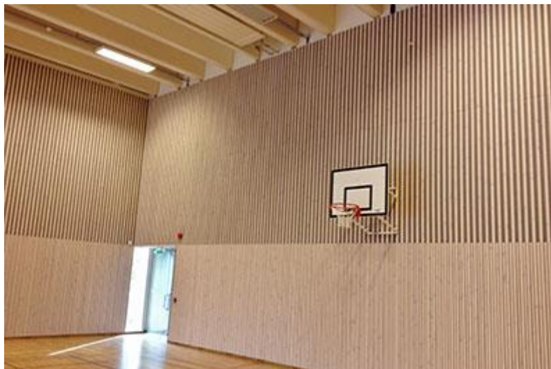
Illustrasjon: eksempel på spilevegg i idrettshall
