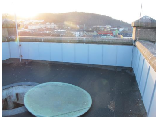
Fig 34 Fløy E, Flatt papptekket tak.
