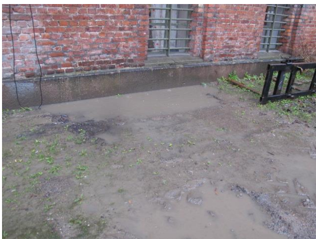
Fig 17 Vann stående mot yttervegg ved regnvær.
