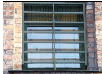
Sålbenk i støpejern. Fløy A B C, samt noe M
