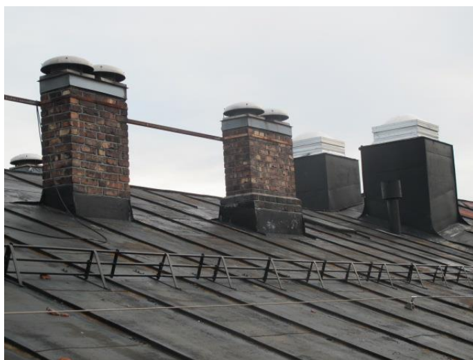
Fig. 37 Eksisterende snøfanger og taksikring
