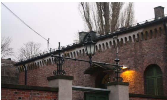
Bilde 1: Kabler i luftstrekk
