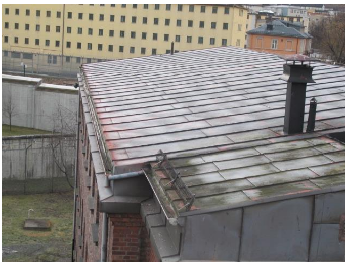
Fig 36 Gesims, bygg D
