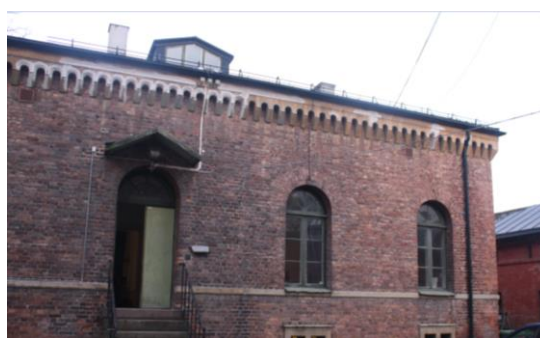
Bilde 2: Kabler i luftstrekk.
