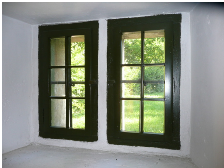
Originale vinduer i kjelleren, fengselsutsalget. Opphavsrett: Statsbygg.
