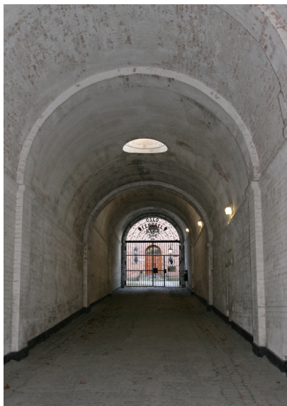
Tunnel fra portal i tårnbygget og inn til fengselsbygningen. Opphavsrett: Statsbygg.
