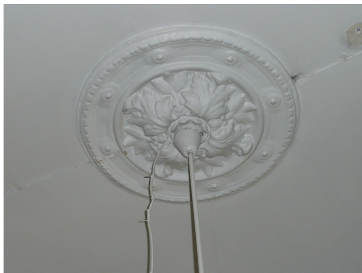
Takrosett i ett av tårnbygningens rom. Opphavsrett: Statsbygg.
