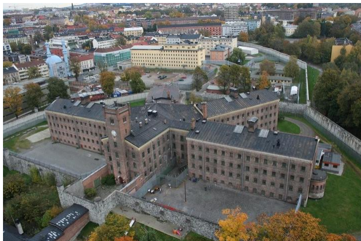
Avdeling A i forgrunnen. Avdeling B og C bakenfor. Opphavsrett: Oslo fengsel.
