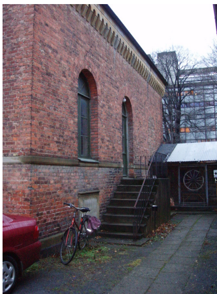
Fasade mot syd/øst. Politihuset i bakgrunnen. Opphavsrett: Statsbygg.
