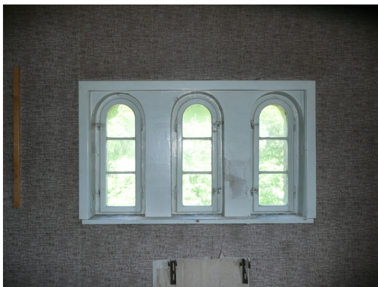
Vinduer som vender mot hovedadkomsten i ett av bygningens to tårrom (4. etg.). Opphavsrett: Statsbygg.
