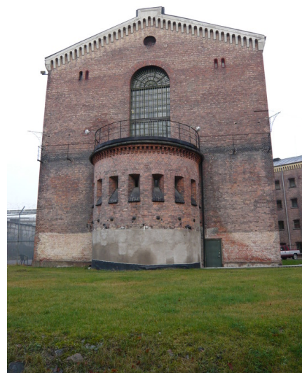
I enden av hver cellefløy var det luftstråler i vifteform for individuell lufting av innsatte. Opphavsrett: Statsbygg.
