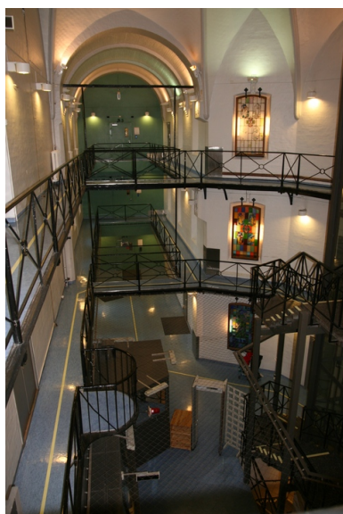
Sentralhallen mot cellefløy. Opprinnelig var det åpent mellom sentralhallen og hver av de tre cellefløyene, og også mellom hver etasje i cellefløyene. Opphavsrett: Statsbygg.
