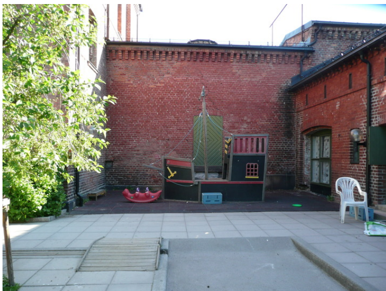
Plass foran direktørbolig, mot mellomgang. Opphavsrett: Statsbygg.
