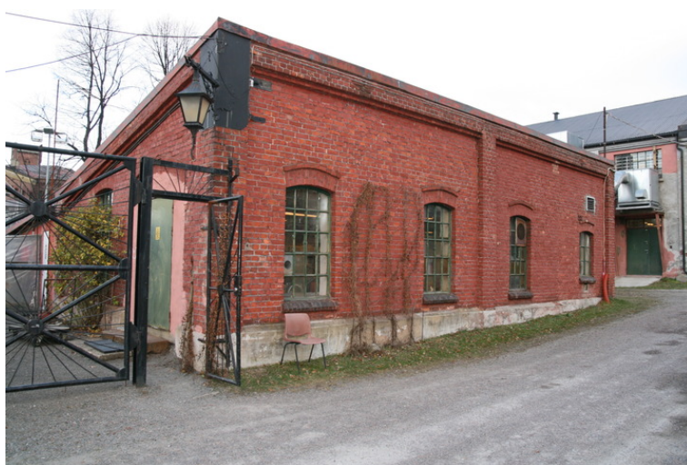
Inngangen til smia, i sørlige enden av bygningen, er gjennom porten til venstre i bildet. Opphavsrett: Statsbygg.
