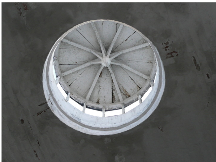
Overlys i tunnel. Opphavsrett: Statsbygg.
