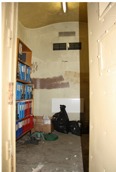
Kjeller, fløy E. Opprinnelig reaksjonscelle med lydsluse, dvs dobbel dør, bøttdo med utvendig tømme Luke og kun indirekte dagslys. Opphavsrett: Statsbygg.
