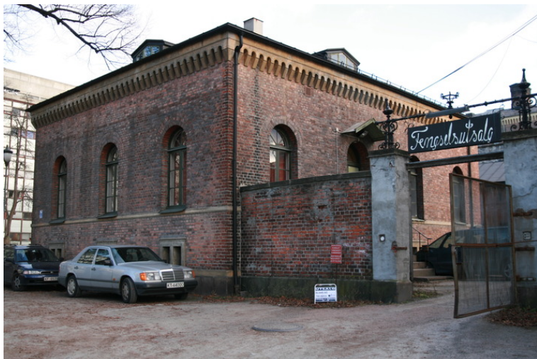
Fasade mot vest og sør. Mur og portal t.h. Opphavsrett: Statsbygg.
