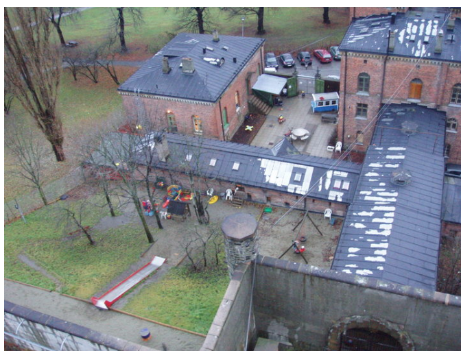
Direktørbolig/Barnehagen sett fra klokketårnet. Foto: Statsbygg Opphavsrett: Statsbygg.
