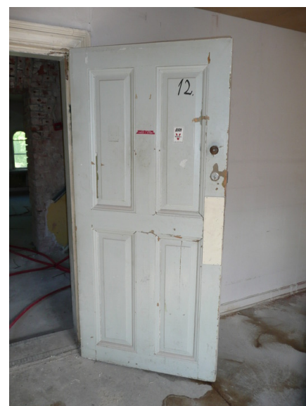
Dør i 1. etasje. Opphavsrett: Statsbygg.
