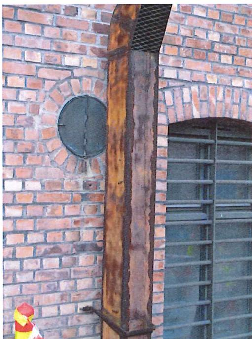
Bildet viser kanal og gitter foran vindu. Begge er tidligere rustbehandlet med blymønje og har innhold av bly over grenseverdiene. Prøvene er analysert med Niton miljøpistol.
