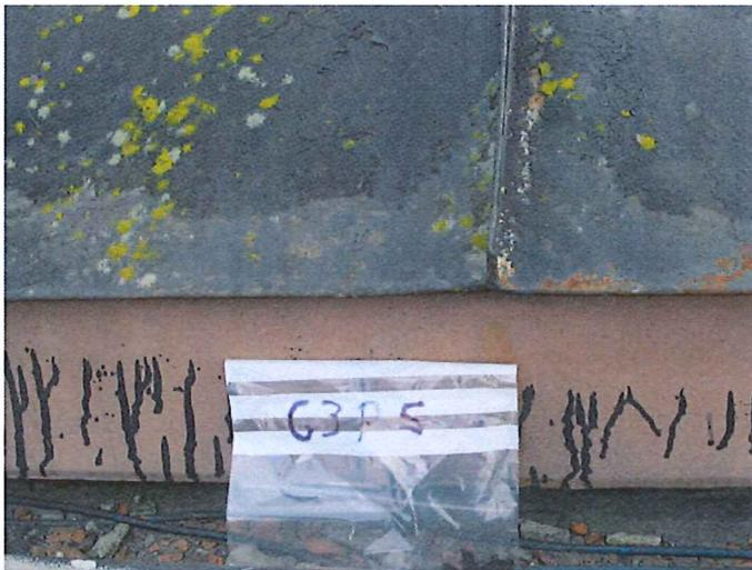
Bildet viser typisk prøvepunkt, der det er tatt prøve av asfaltbelegg på takplater for kontroll av PAH. Prøven er analysert i laboratorium.
