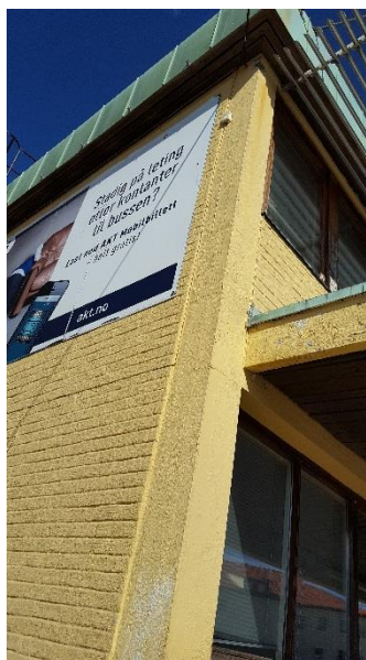
Bilde 8: Takstikk med treplanker. Gulmalt fasade som er lavforurenset.
