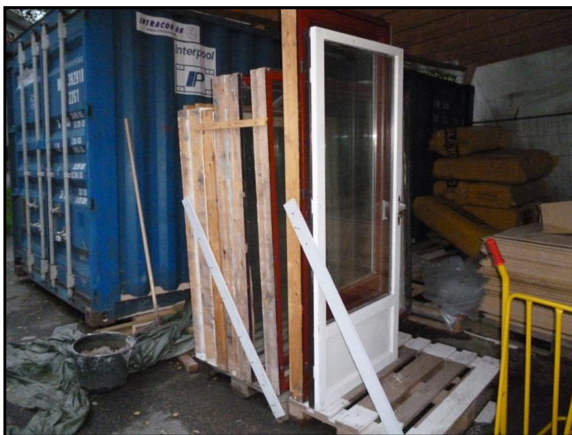
Figur 2: Slik kan vinduer og balkongdører klargjøres for transport.
