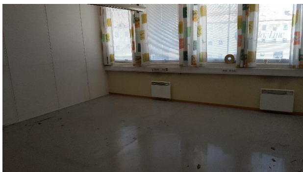
Bilde 7: Vinylbelegg på gulv, isolerglassvindu, 2.etasje.
