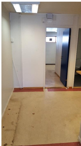
Bilde 6: Vinylbelegg på gulv, 1.etasje.
