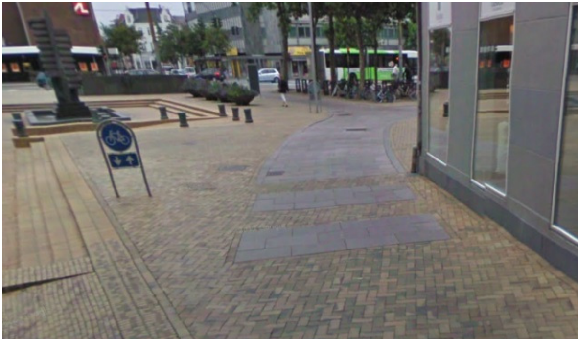
Figur 14: Eksempel på overgangssone. Vestergade, Odense. Foto: gogels gatebilder
