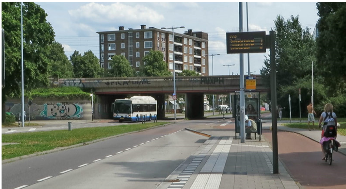
Figur 16: Sykkelfelt som passerer bak holdeplass. Sykkelanlegget er markert med farge og høydeforskjell. ( http://bicycledutch.files.wordpress.com/2013/09/nijenoord2013.jpg )
