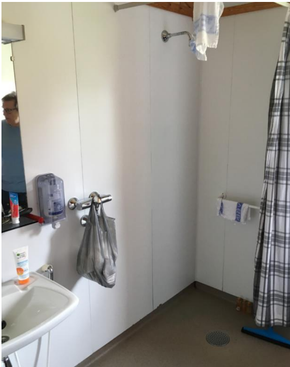
4. Bilde viser generelt dusjhjørne på bad 1-7.
