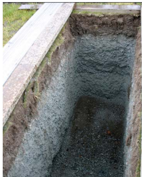
Kistegrav gravd i 0-22 mm masser. Gravveggene står helt perfekt.
