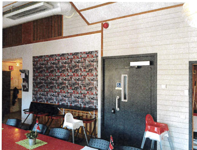
Bilde viser 2. etasje. Det er ca. 3300 mm fra gulv til skråtak over heisdører.
