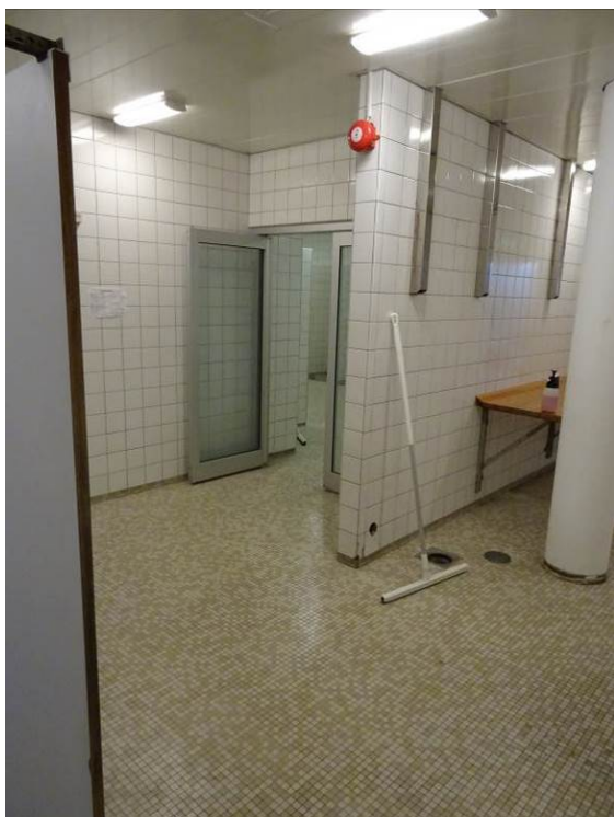
Foto nr. 48 Damegarderobe, komplett oppgradering slik som herregarderobe medtas.
