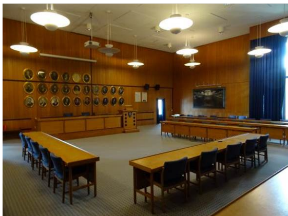
Foto nr. 44 Tepper fra byggeår, stram lukt og noe tilsmussing.
