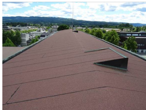
Foto nr. 27 Omtekket tak på høybygg mot vest. Tilstanden er god.
