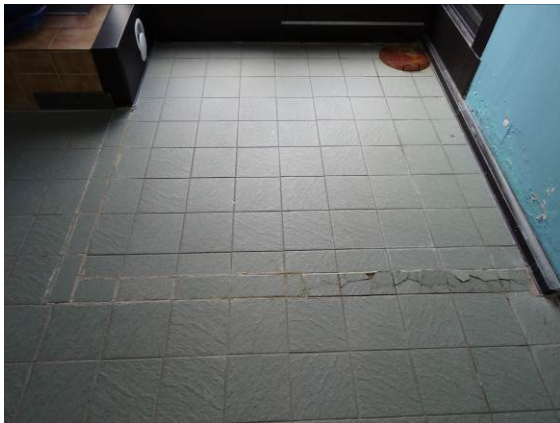
Foto nr. 60 Knuste fliser og bom.
