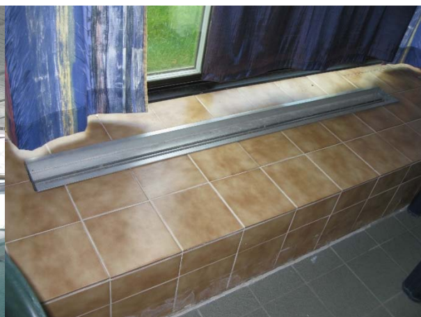
Bilde 32: Vinduer i svømmehall
