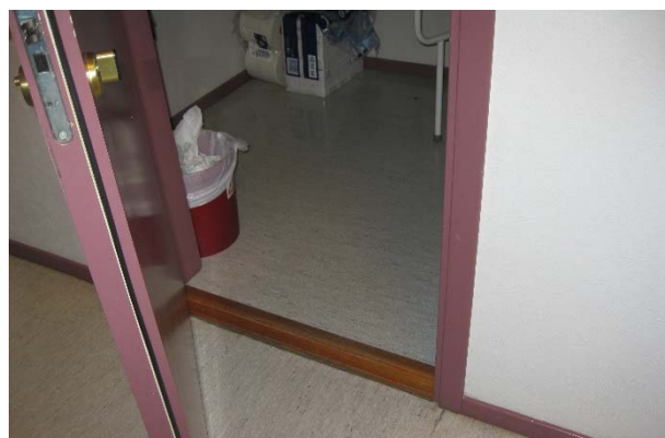
Bilde 27: Toalett med terskel som hindrer overstrømning
