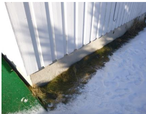
Figur 12: Utvendig malt grunnmur
