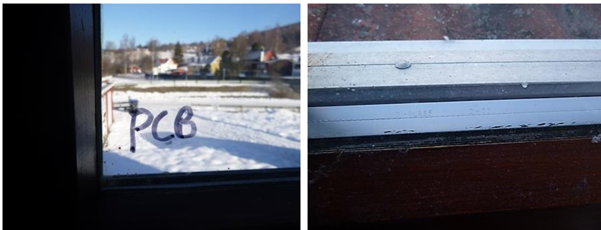
Figur 3: PCB-holdige isolerglassvinduer
