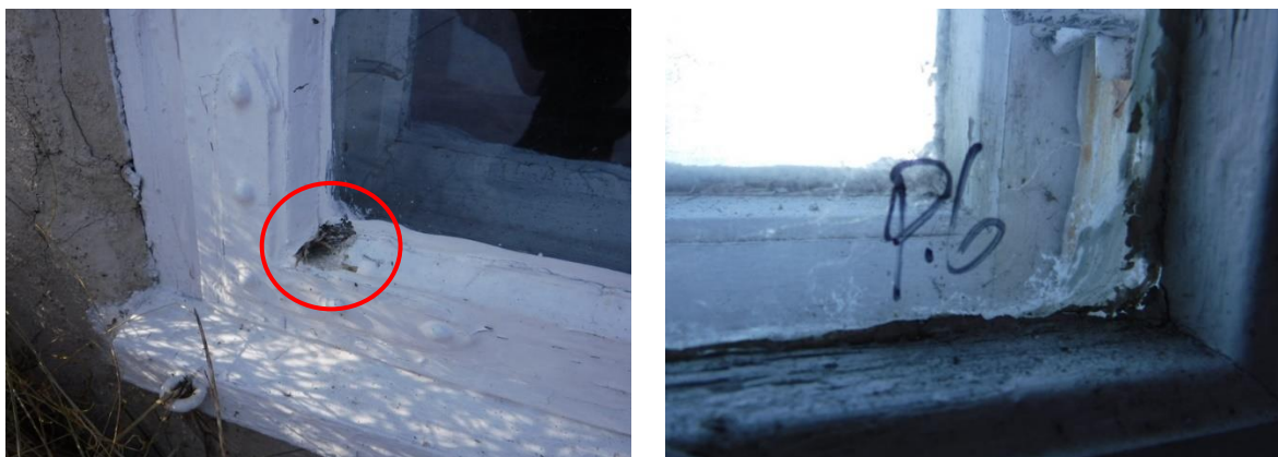
Figur 21: Prøvepunkt nr. 6, inneholder ikke asbest
