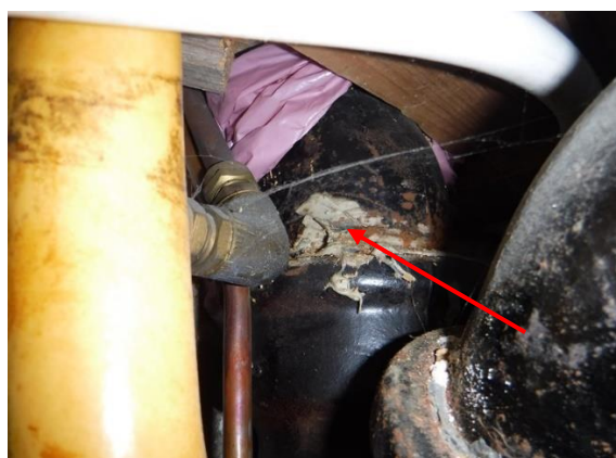
Figur 23: Asbestholdig fyllmasse
