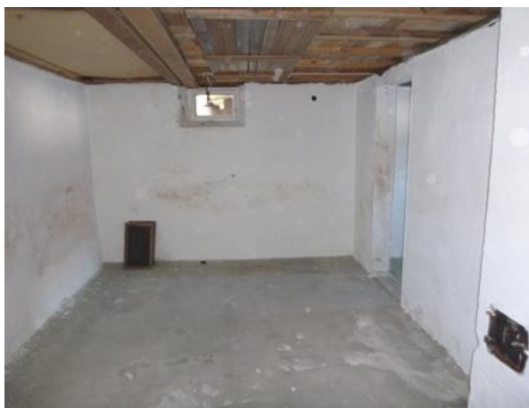
Figur 9: Malte vegger i kjeller
