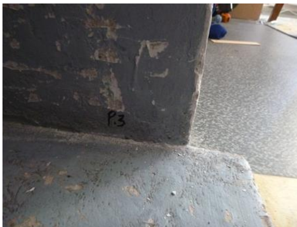
Figur 7: Maling fra pipe
