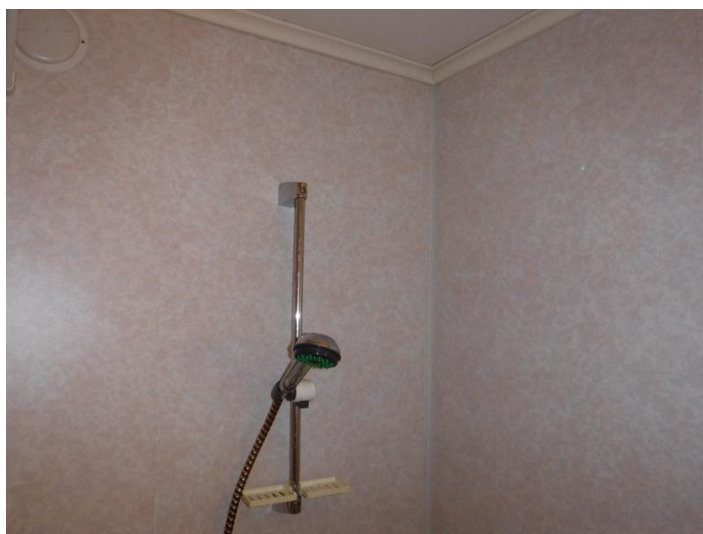
Figur 19: Pentaklorfenol plater på bad
