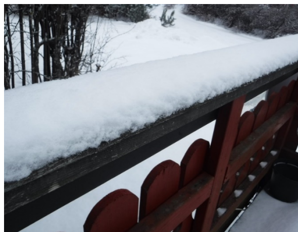
Figur 9: CCA-impregnerert terrasserekkerk
