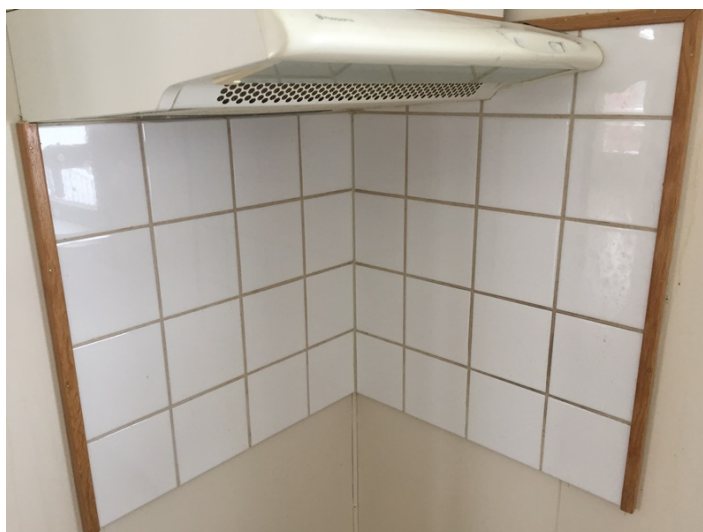
Figur 5: Keramiske fliser leveres som forurenset masse
