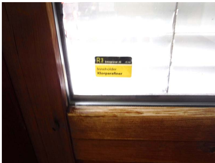
Figur 3: Merket isolerglass som inneholder klorparafiner
