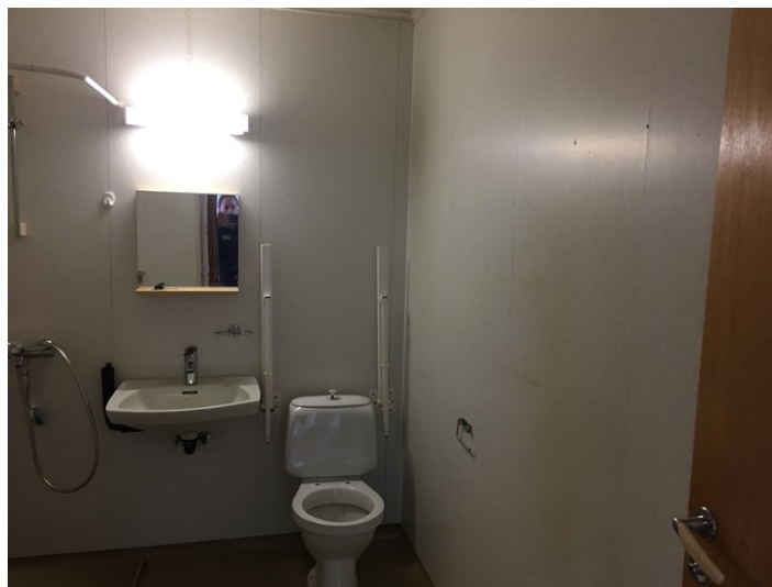
Figur 11: Baderomsplater, farlig avfall
