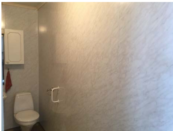
Figur 11: Våtromsplater på bad, PCP
