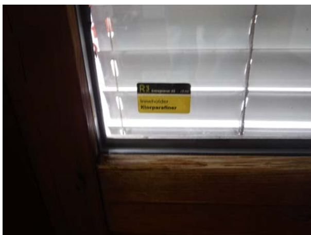
Figur 4: Isolerglassrute inneholdende klorparafiner
