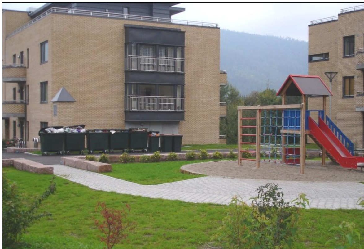
Typisk eksempel på beholderplassering med potensielle konfliktpunkter, foto: Mepex Consult AS
