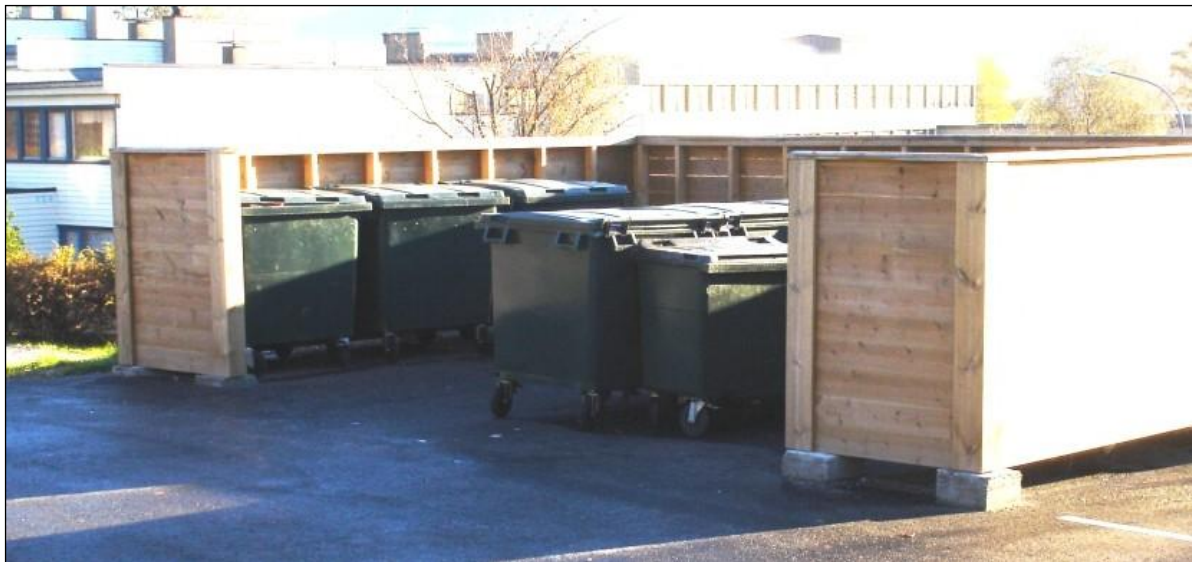
Oppstillingsplass – skjermet med vegger, foto: Mepex Consult AS
