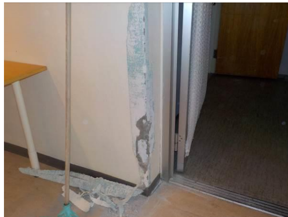
Bilde 74 viser prøvetakingssted av betong i vestfløy. Betongen er ikke forurenset med PCB eller tungmetaller.
