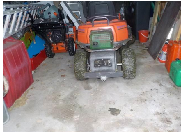
Bilde 79 viser flekker med oljesøl på betonggulv i garasje, vestfløy.
