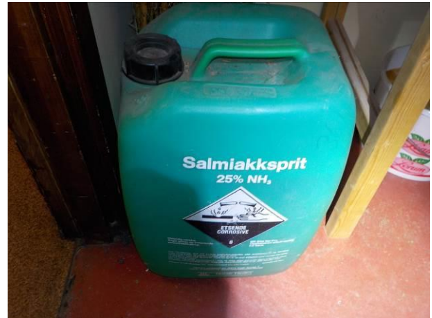
Bilde 56 viser kanne med salmiakksprit NH_3 som ble observert i rom med eldre kjøleanlegg.
