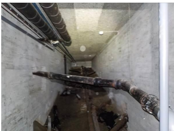
Bilde 71 viser umalt betong i kulvert i østfløy. Betongen er ikke forurenset med PCB eller tungmetaller.
