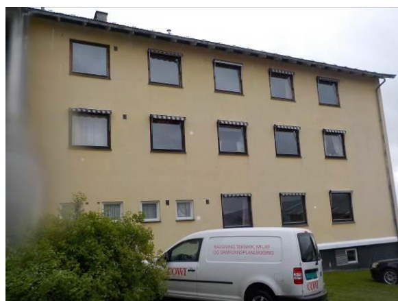
Bilde 69 viser gulmaling på fasade på østfløy. Gulmalingen er forurenset med sink.
