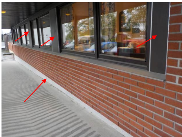
Bilde 25 viser asbestholdige eternittplater på grunnmur langs rullestolrampe på vestfløy. Brune asbestplater er montert mellom vinduer.
