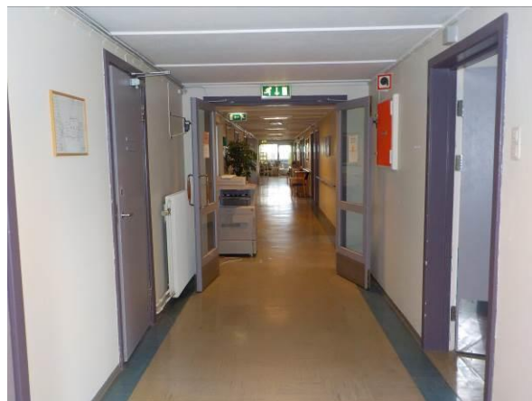
Bilde 12 viser grå og blå vinylfliser på gulv i 1. etasje i østfløy. Det ble ikke påvist asbest i blå eller grå vinylfliser. Flisene skal håndteres som farlig avfall med ftalater, se kap. 3.6.
