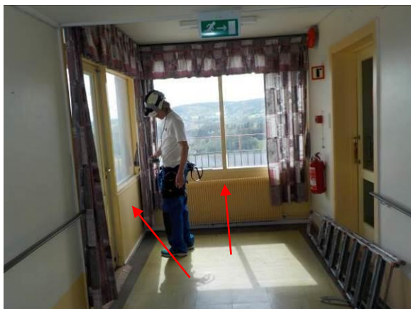
Bilde 10 viser prøvetaking av kitt mellom glass og ramme på ruter som er merket "Thermopane". Platene under vinduene er asbestplater.
