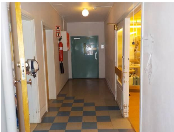
Bilde 41 viser grå og blå vinylfliser i gang mellom kjøkken og spisesal i underetasje, østfløy.
