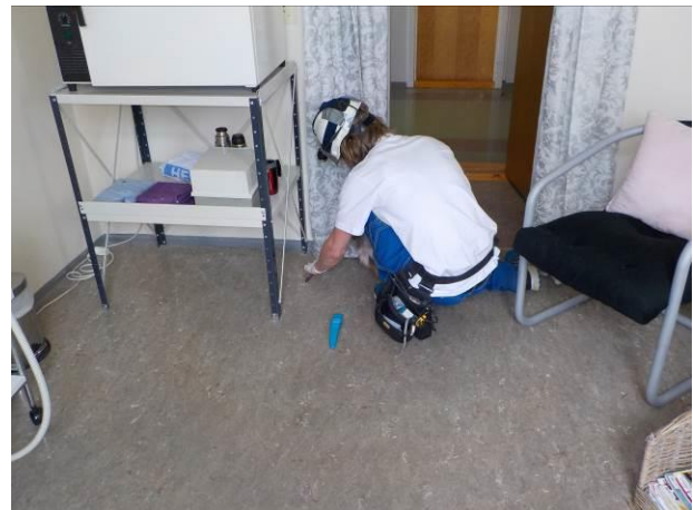
Bilde 43 viser sjekk av type gulvbelegg, og antall lag belegg i pasientrom i 1. etasje i østfløy.
