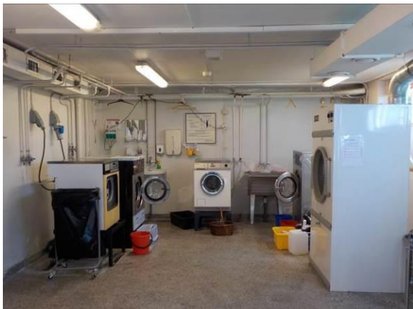
Bilde 70 viser terrazzobelegg på gulv i vaskerom i kjeller i østfløy. Terrazzoen er ikke forurenset med PCB eller tungmetaller.
