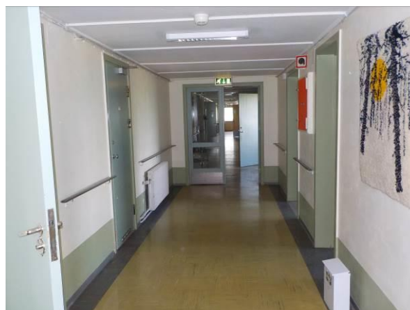
Bilde 13 viser gule og grå vinylfliser på gulv i 2. etasje, østfløy. Det ble ikke påvist asbest i gule eller grå vinylfliser. Flisene skal håndteres som farlig avfall med ftalater, se kap. 3.6.
