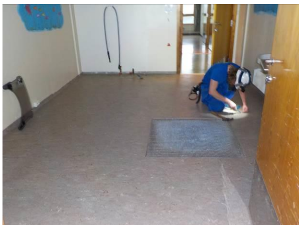
Bilde 45 viser sjekk av vinylbelegg på bad i 2. etasje, vestfløy
