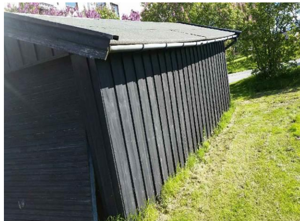
Bilde 87 viser takpapp på tak på frittstående garasje.
