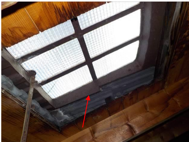
Bilde 85 viser takvindu i 3. etasje i østfløy. Takpapp ligger under takstein, og var tilgjengelig for inspeksjon fra dette vinduet.
