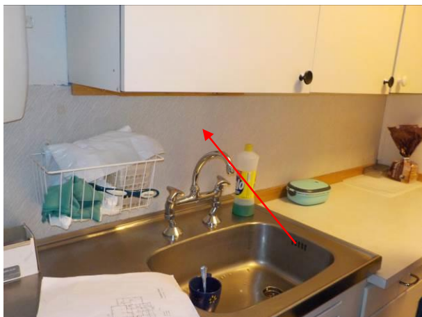
Bilde 44 viser vinyltapet på vegg mellom over- og underskap på kjøkken i 1. etasje, østfløy.
