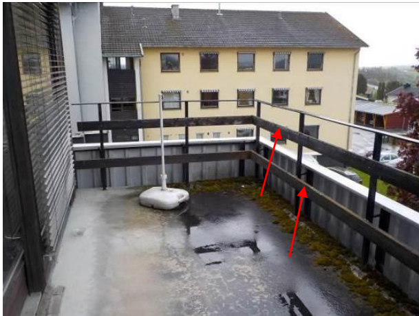
Bilde 34 viser CCA-impregnert trevirke på gjerde på balkong på vestfløy.
