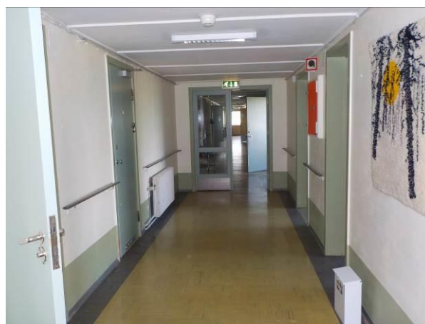
Bilde 64 viser hvitmaling på vegg i 2. etasje, østfløy. Hvitmalingen er forurenset med PCB og tungmetaller.
