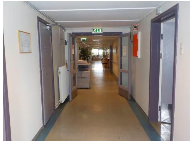
Bilde 42 viser grå og blå vinylfliser på gulv i gang i 1. etasje, østfløy.
