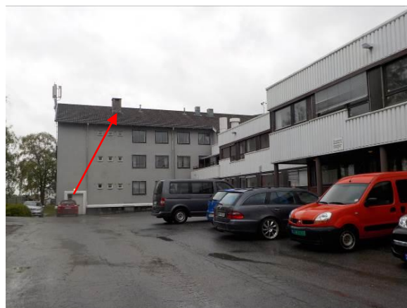
Bilde 82 viser en fyringspipe og to ventilasjonspiper på tak på grå del av østfløy.
