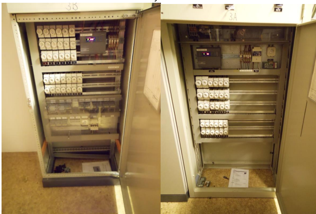
Bilder: Teknisk rom nordfløy: el.tavler som skal skiftes ut.
