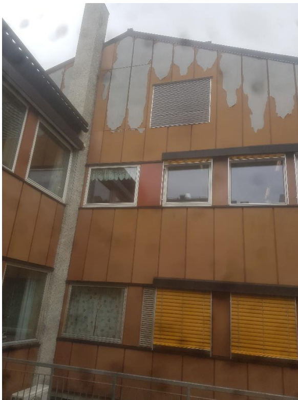
Bilder over: Yttervegsrist i gavlvegg nord (bxh 1,5x1,3m). Transportåpning til teknisk rom nordfløy.
