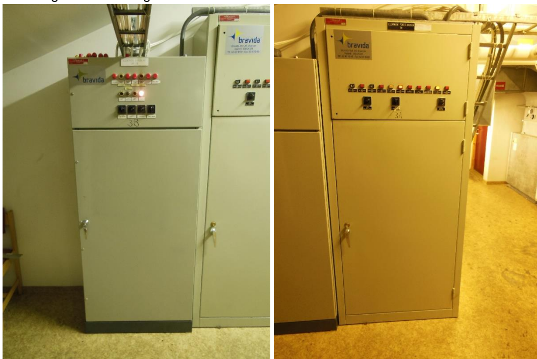
Bilder: Teknisk rom nordfløy: el.tavler som skal skiftes ut.
