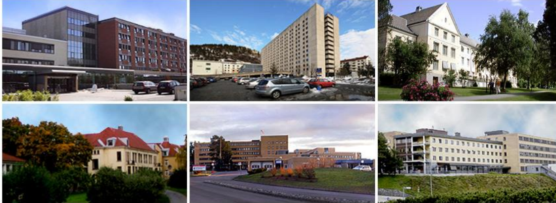
Figur 2 – Fra venstre: Bærum sykehus, Drammen sykehus, Lier sykehus, Psykiatrisk avdeling Blakstad, Ringerike sykehus, Kongsberg sykehus
