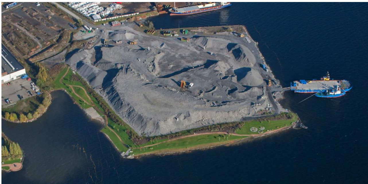
Figur 6-27: Utfyllingen ble brukt som masselager i flere år.
