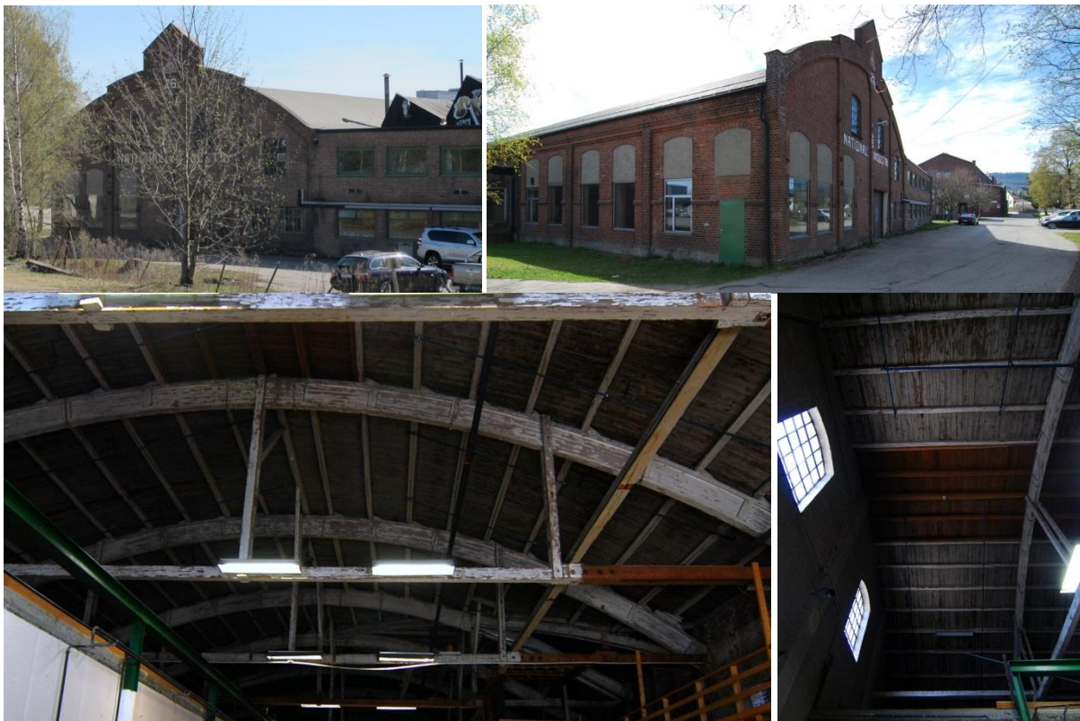
Figur 6-17: Hovedblokka på de to øvre bildene har i sør et anpasset men strammere tilbygg fra 1943. Interiøret preges av den kulturhistorisk verdifulle takkonstruksjonen i limtre.
