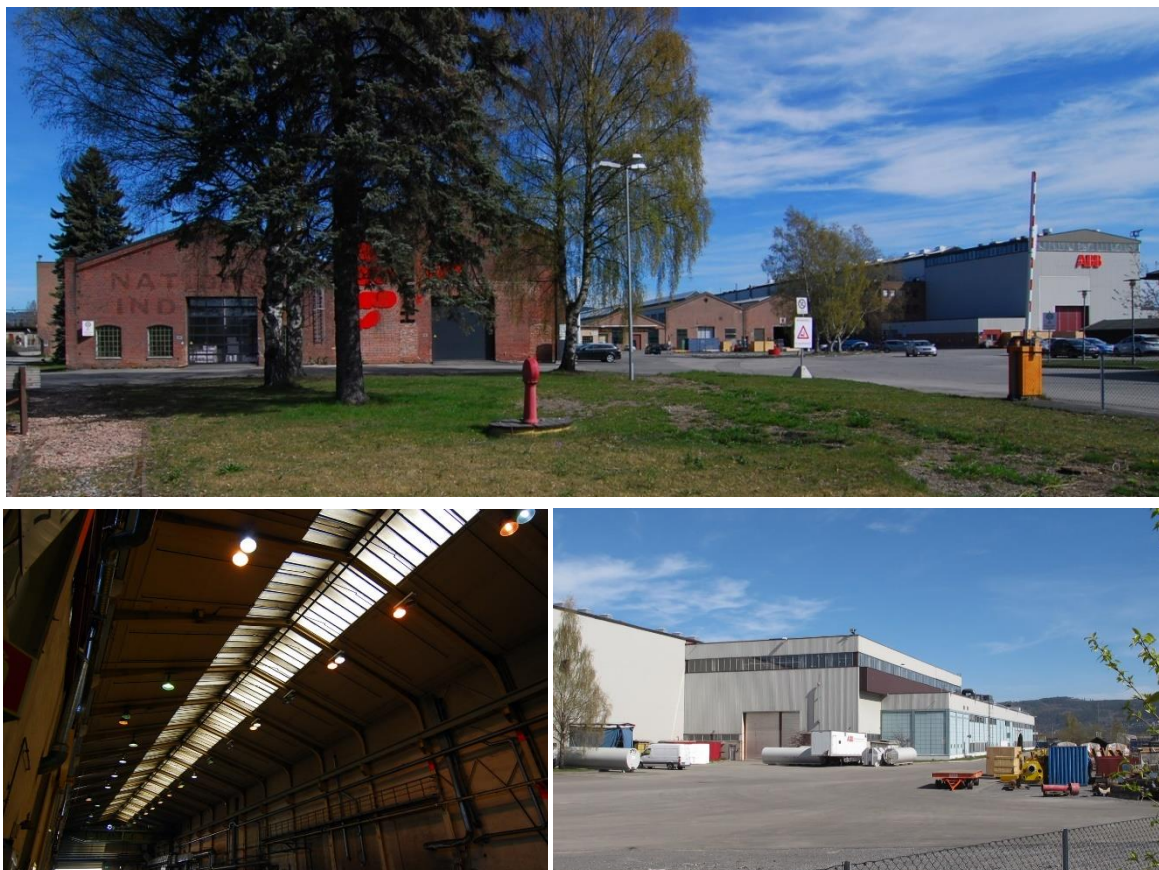
Figur 6-20: Til høyre i øverste bilde står den fremre delen av den store hallen fra 1972 i delmiljø 3. Formspråket minner tydelig om den gamle maskinhallen fra 1912, men materialene og proporsjonene gir en kontrasterende effekt på kulturmiljøet i sin helhet. På de to nedre bildene ses den 17 meter høye himlingen med overlys til venstre og 1963/1977-års travershall samt et tilbygg fra 1993.
