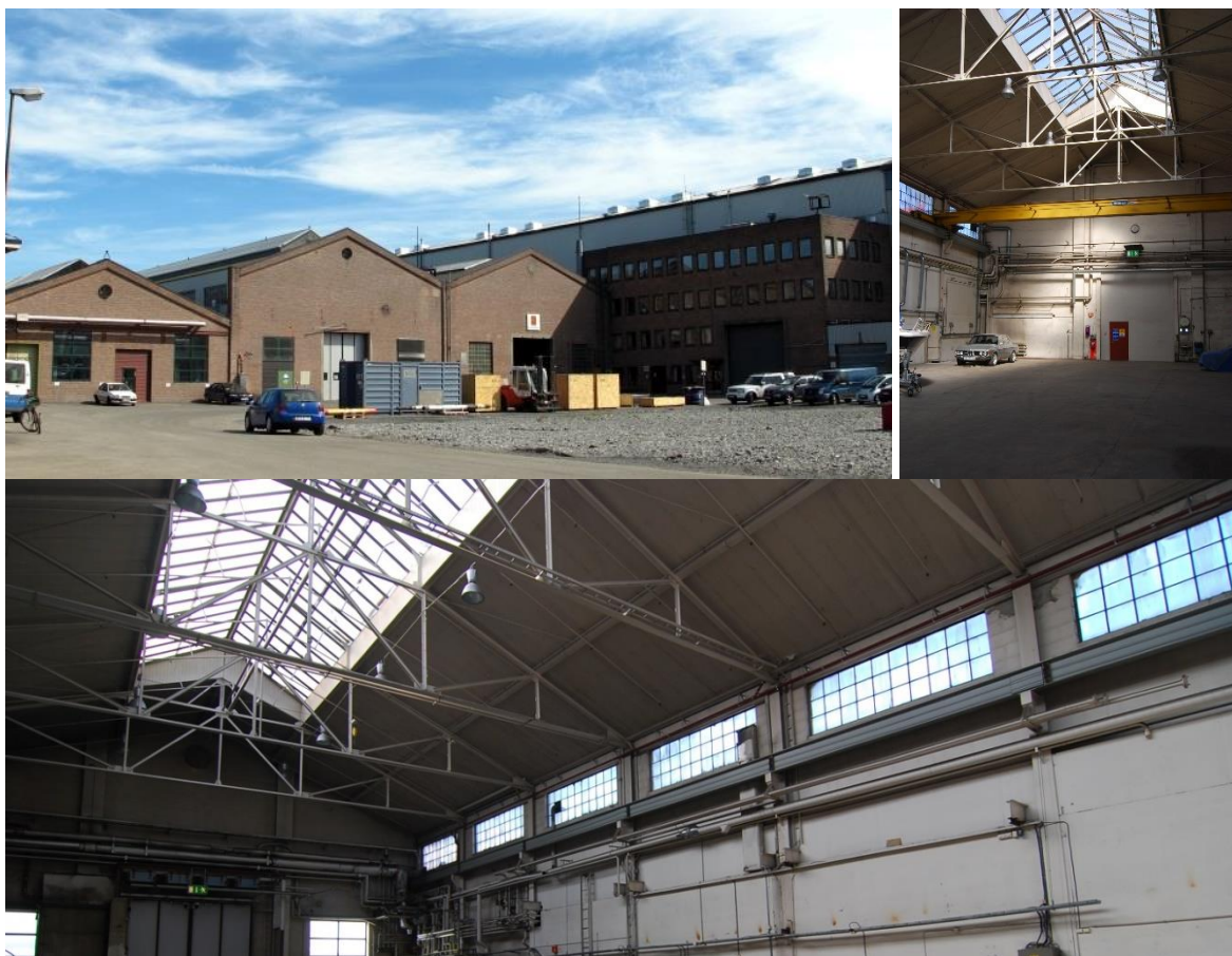
Figur 6-19: Delmiljø 2 preges av store haller fra etterkrigstiden. De ytre rammene for gestaltning minner om de eldre bygningene i delmiljø 1, men materialbruk og volum er mere moderne og større.
