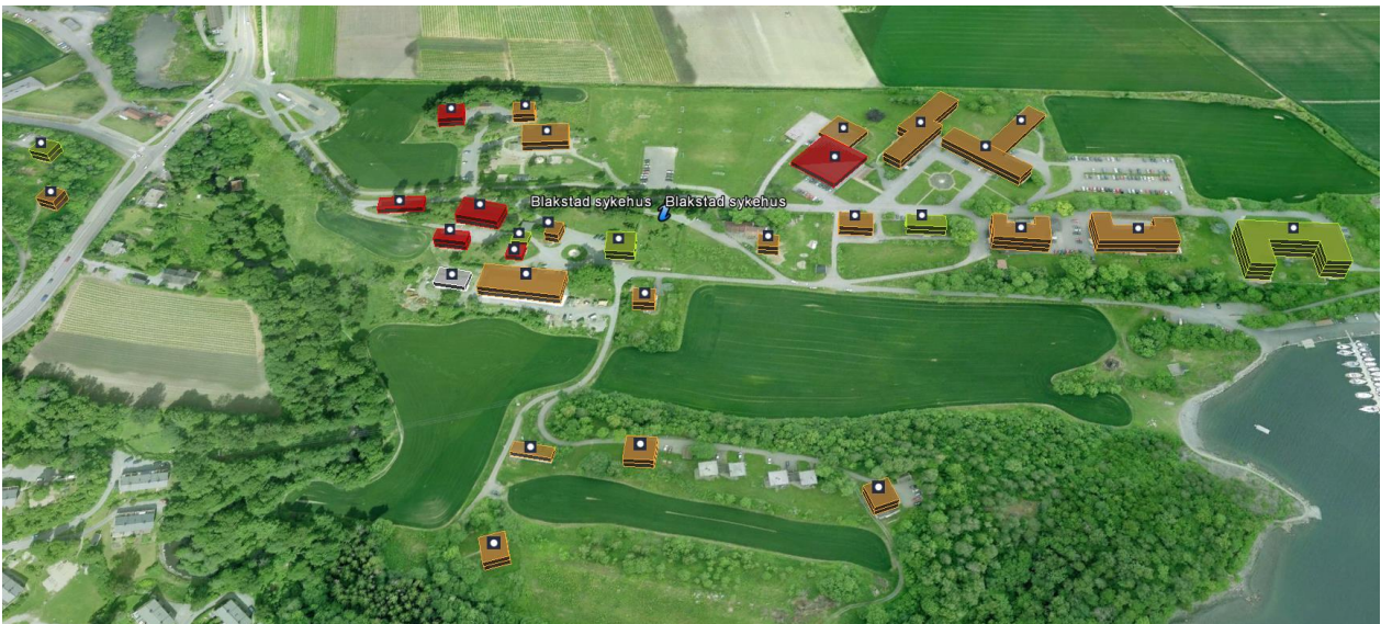
Figur 8. Blakstad sykehus, teknisk tilstand
