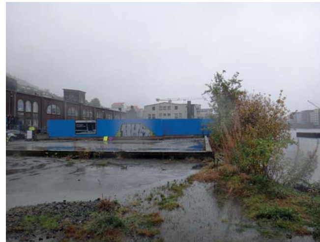
Lokasjonen er per idag et anleggsområde, grunnet etablering av Småpudden.
