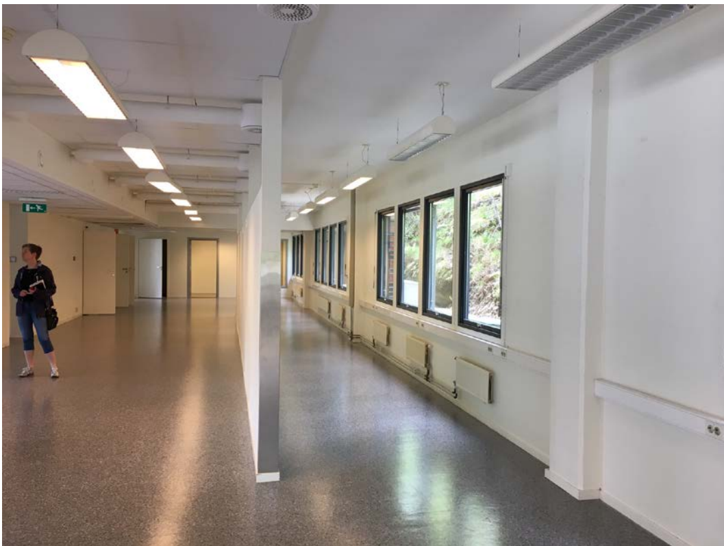
Bilde - kontordel, sør
