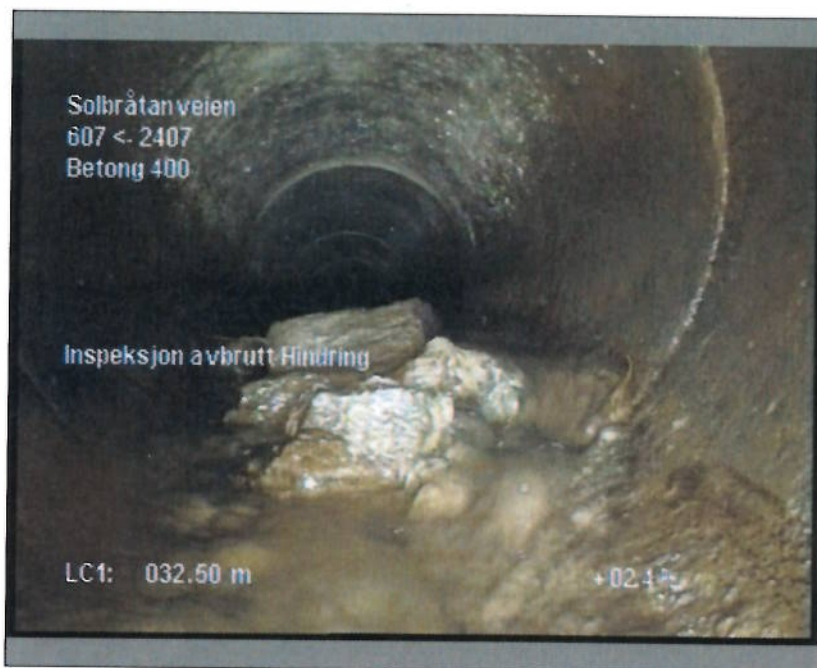
Foto: S_Sectionname_32,5_104348_3_A.JPG 32,5m, Inspeksjon avbrutt Hindring
