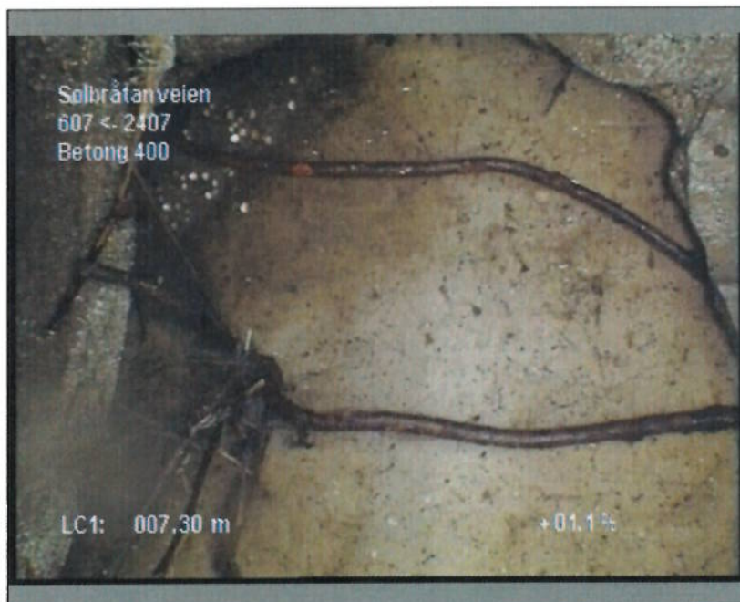
Foto: S_Sectionname_7,3_103905_3_A.JPG 7,3m, Puktreparasjon, fra 01 til 04 Kl., Reparert hull
