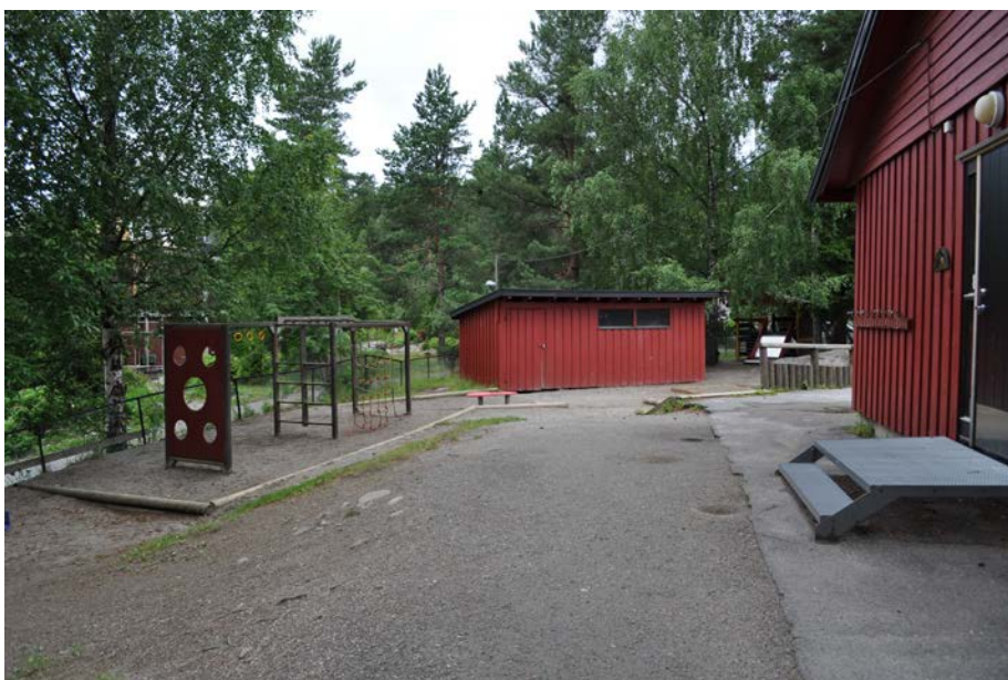
Eksisterende barnehage og bode
