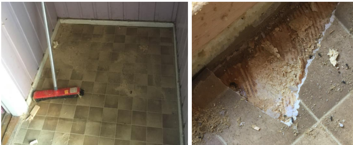
Bilde 09 – Gulvbelegg i vindfang og varmestue, lim under belegg var ikke sort, dvs ikke asbestholdig.
