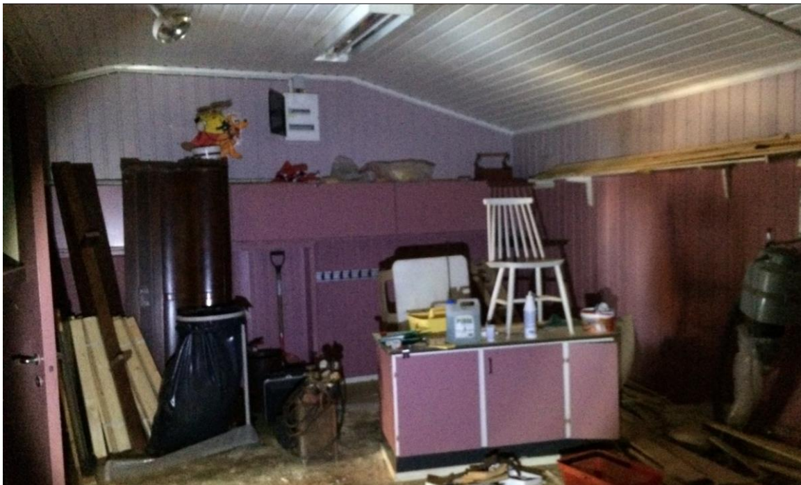
Bilde 08 – Innvendige malte flater: vindfang og varmestue
