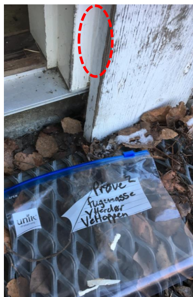
Bilde 02 – Prøvepunkt 2, Velhuset
