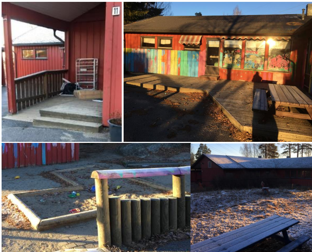
Bilde 21 – Impregnert trevirke observert på eiendommen.
