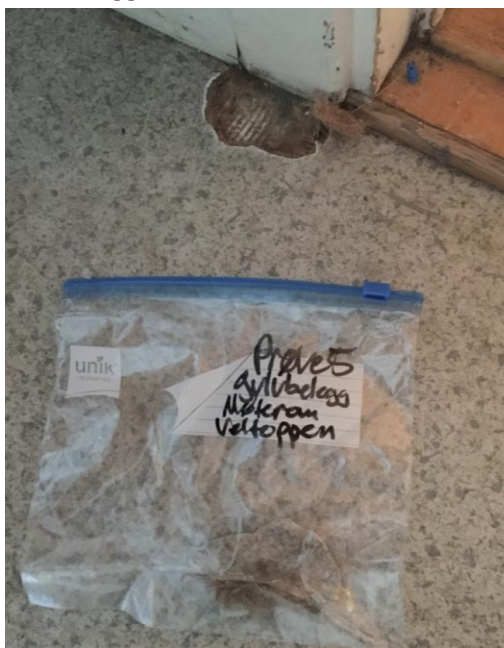
Bilde 05 – Prøvepunkt 5, Velhuset
