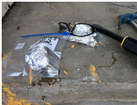
Bilde 08 – Prøvepunkt 8, Velhuset
