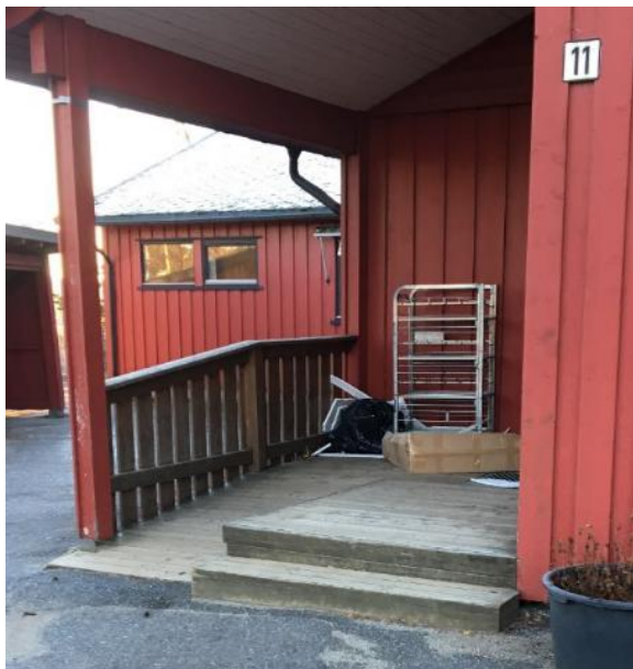
Bilde 16 – Prøvepunkt 16, Hovedbygning
