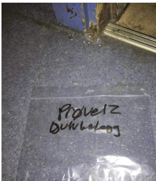
Bilde 12 – Prøvepunkt 12, Hovedbygning
