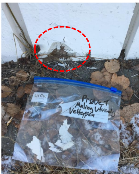
Bilde 01 – Prøvepunkt 1, Velhuset
