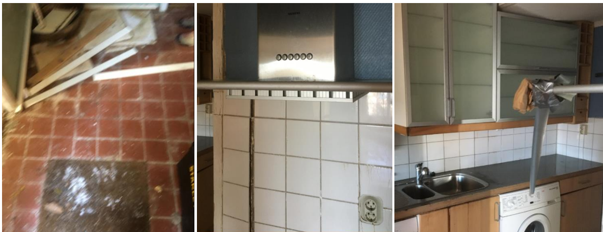
Bilde 13 – Keramiske fliser i 1. etg: gulv ved hovedinngang, kjøkkeninnredning
