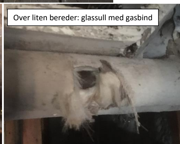
Bilde 18 – Rørisolasjon tilknyttet varmtvannsanlegg i kjeller: mineralull, cellegummi, isopor, m.m. (1 av 2)
