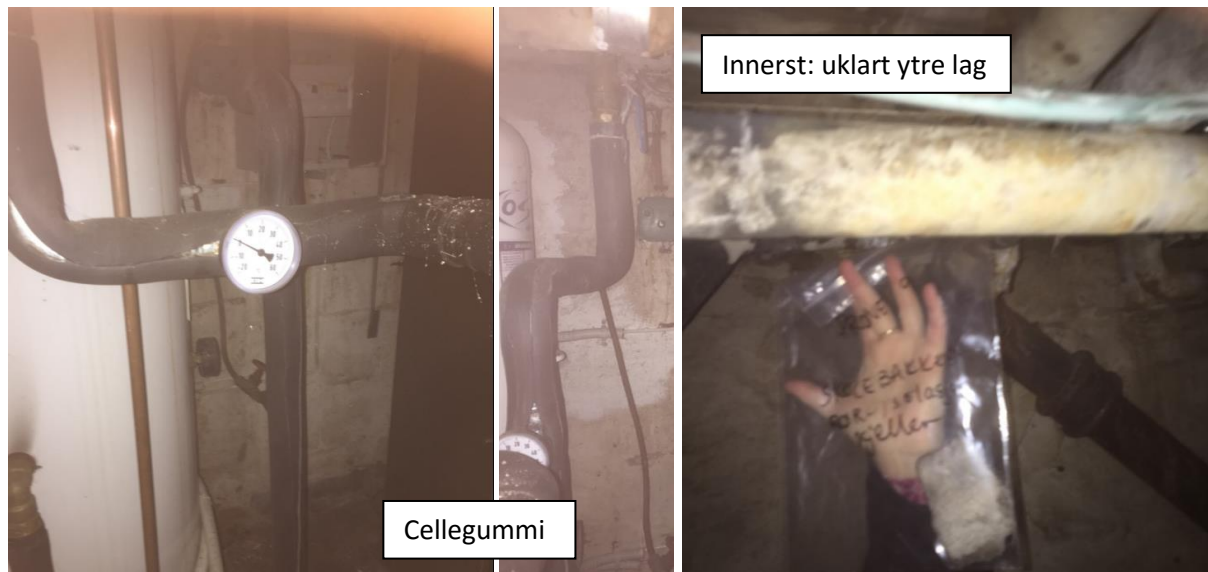
Bilde 19 – Rørisolasjon tilknyttet varmtvannsanlegg i kjeller: mineralull, cellegummi, isopor, m.m. (2 av 2)
