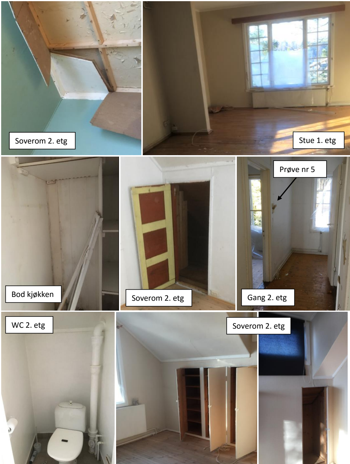
Bilde 15 – Malte flater inne i enebolig: veggplater med og uten tapet
