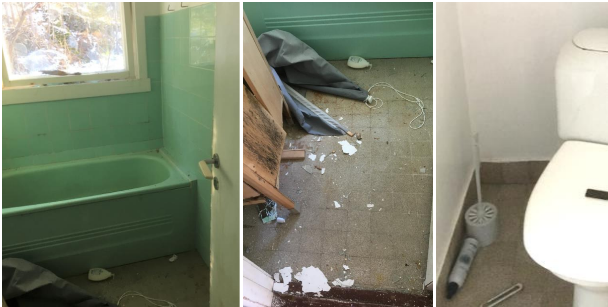
Bilde 12 – Keramiske fliser i 2. etg: vegger og gulv på bad, samt gulv på WC
