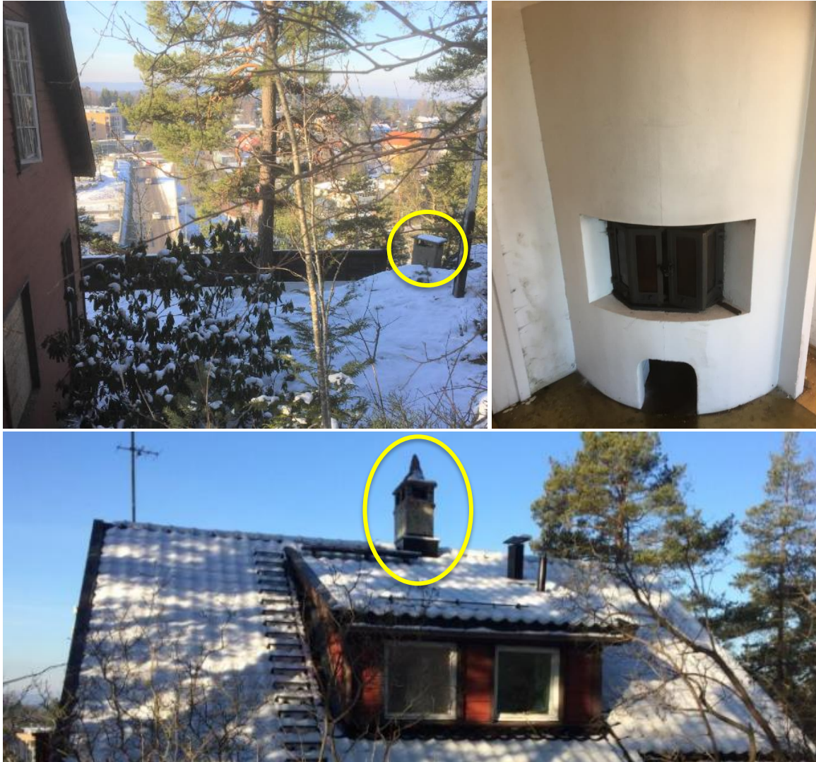
Bilde 25 – Pipeløp, peis og utendørs grillplass med sannsynlig PAH-forurenset betong og tegl
