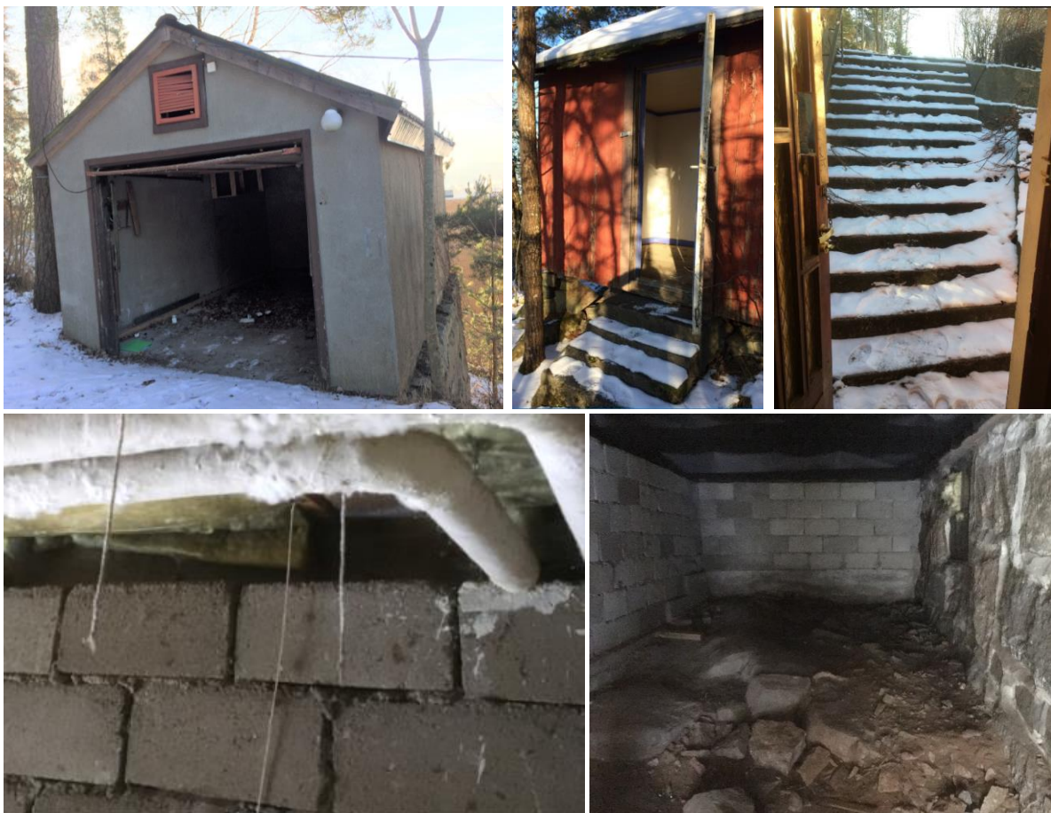
Bilde 10 – Betongkonstruksjoner: garasje, trapp lekestue, trapp hovedinngang, fundament i deler av kjeller
