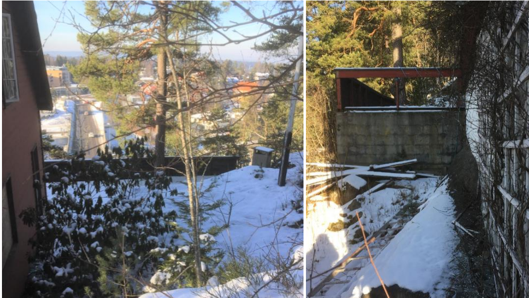
Bilde 23 – Impregnert trevirke på terasse ved 1. etg
