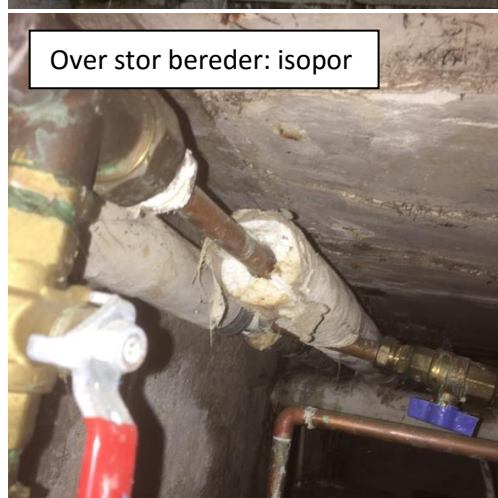
Bilde 18 – Rørisolasjon tilknyttet varmtvannsanlegg i kjeller: mineralull, cellegummi, isopor, m.m. (1 av 2)
