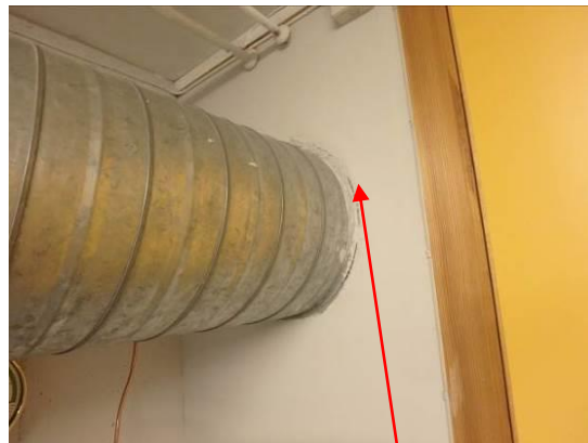
Bilde 25 viser fugemasse rundt rørgjennomføring. All myk fugemasse som berøres skal håndteres som farlig avfall med klorparafiner.
