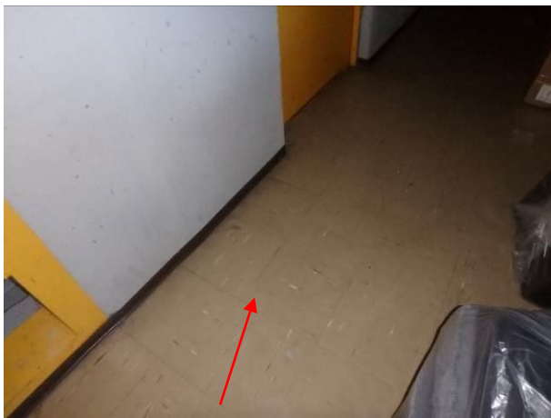
Bilde 1 viser vinylfliser i gang i kjeller som ble analysert for asbest. Det ble ikke påvist asbest i vinylflisene.
