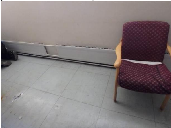
Bilde 4 viser vinylfliser i trimrom i kjeller som ble analysert for asbest. Det ble ikke påvist asbest i vinylflisene.
