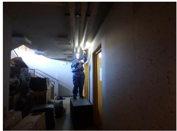
Bilde 2 viser prøvetaking av rosa pulver i rørbend. Det ble ikke påvist asbest i rørisolasjonen.
