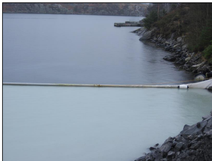
Figur 5. Eksempel på barriereeffekt og bruk av siltgardin /9/.
