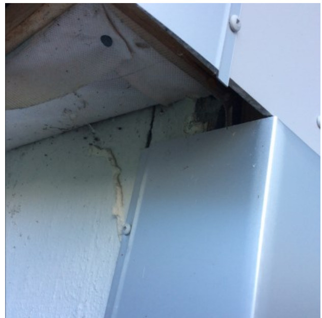
Bilde 5: En av to 5 cm x 5 cm eternittplater som ble påvist ved inngangen mot vest (midt på bildet)
