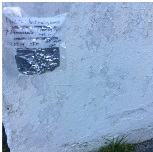
Bilde 16: Utvendig hvit maling på betong er ikke påvist å inneholde PCB,
