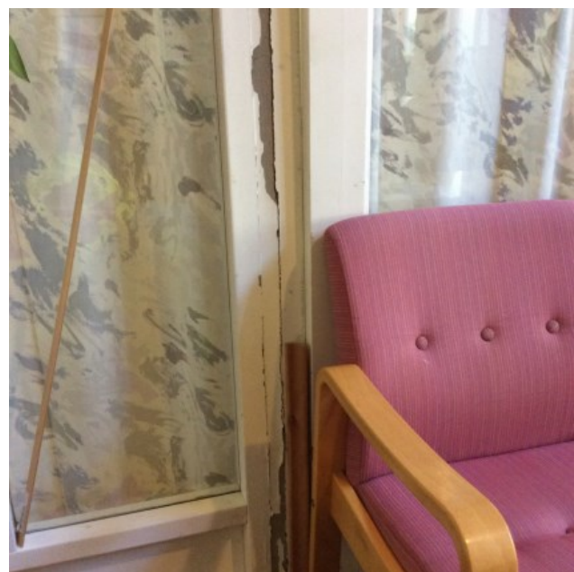
Bilde 38: Hvit maling på treverk ble prøvetatt. Prøven påviste ikke tungmetaller over gjeldene grenseverdier
