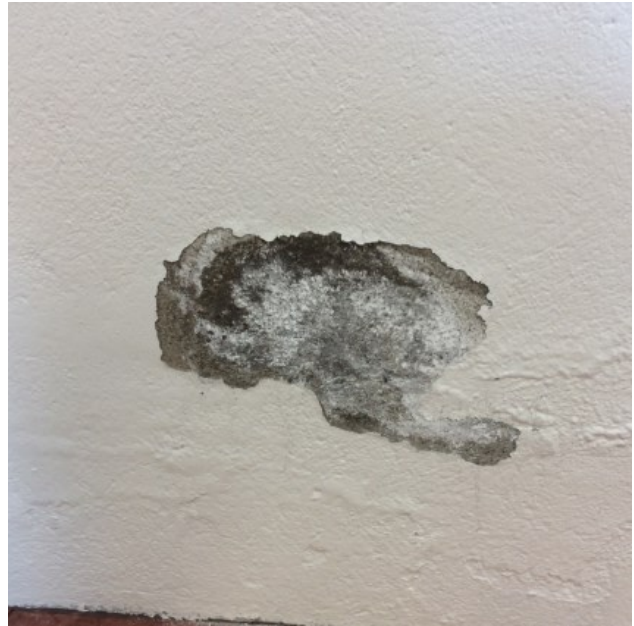
Bilde 24: Veggmaling på biblioteket er ikke påvist å inneholde tungmetaller over gjeldene grenseverdier (1.etg)
