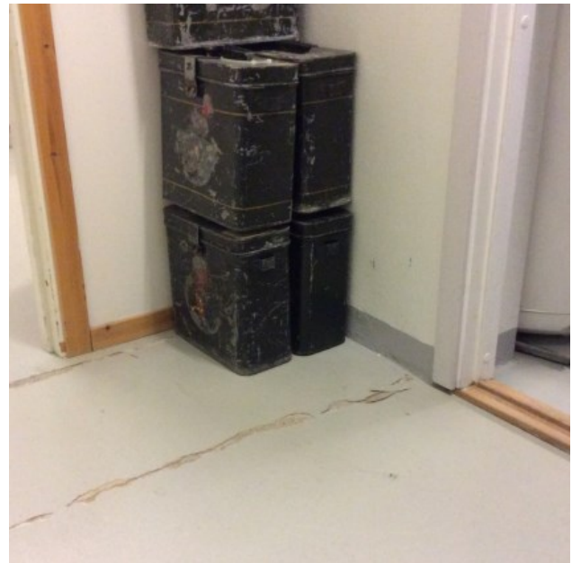
Bilde 28: Gulvmalingen er påvist å inneholde krom over normverdien (1.etg)
