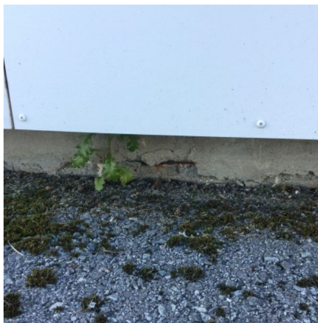
Bilde 46: Utvendig hvit maling på betong er ikke påvist å inneholde PCB 7
