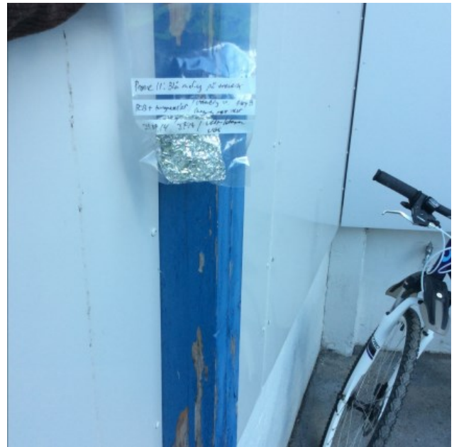
Bilde 20: Det ble ikke påvist PCB 7 i utvendig blå maling
