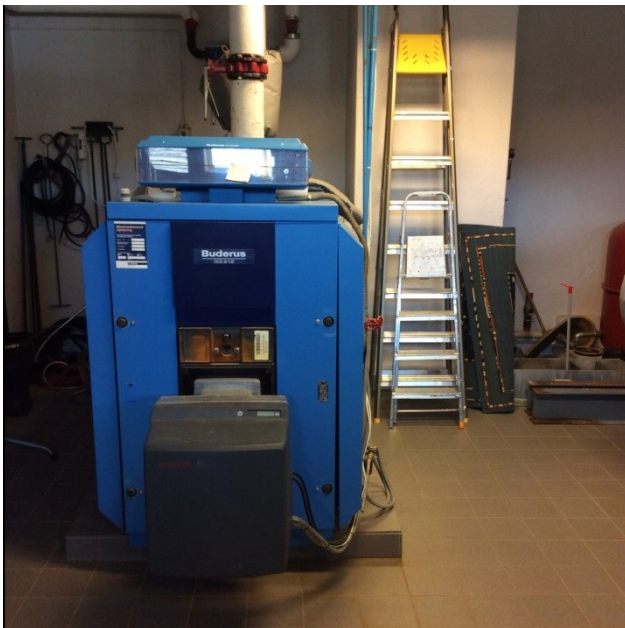
Bilde 63: Oljefyringssystem
