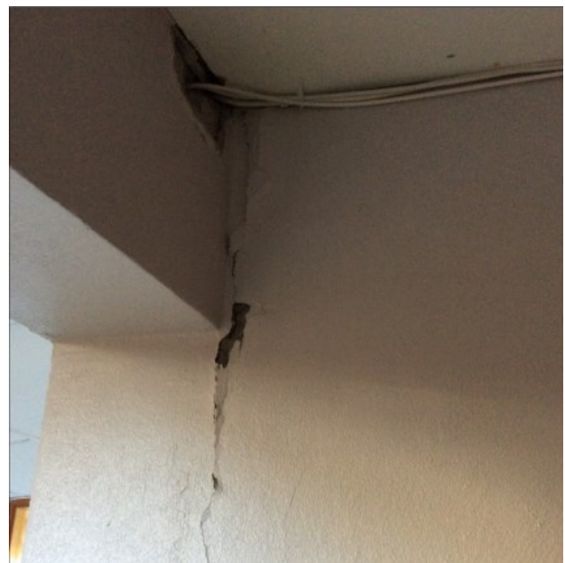
Bilde 30: Maling og puss i gang inneholder ikke tungmetaller over gjeldene grenseverdier, men er klassifisert pga innhold av PCB 7 (1.etg)
