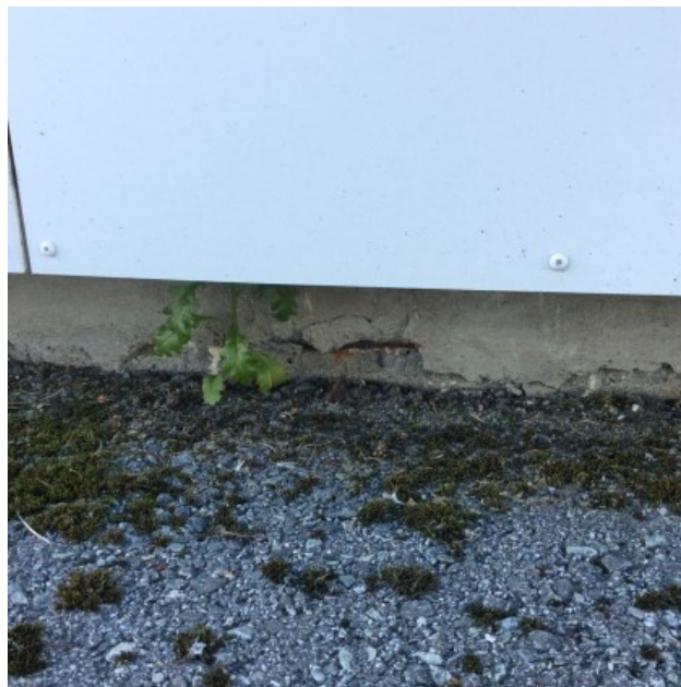
Bilde 18: Utvendig hvit maling på betong er ikke påvist å inneholde PCB 7
