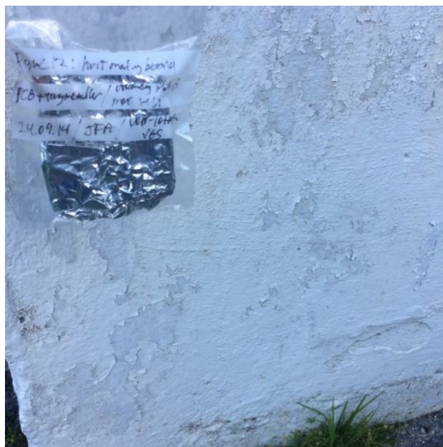
Bilde 44: Utvendig hvit maling på betong er ikke påvist å inneholde PCB 7
