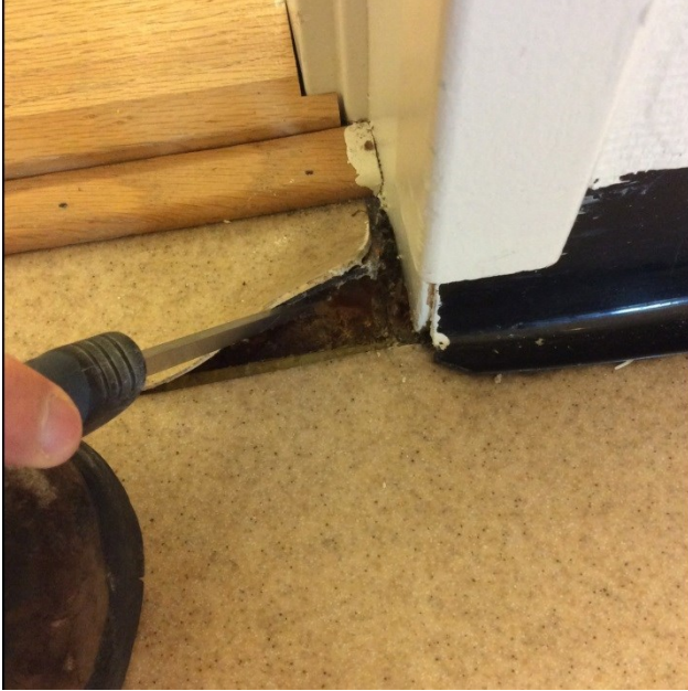
Bilde 49: 2 lag med vinylgulvbelegg og vaskelist
