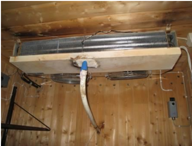
Bilde 42: Installasjon i kjølerom u.etg.
