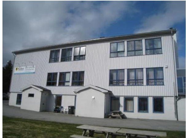
Bilde 47: Eksempelbilde. Asfalterte områder ved bygningen.
