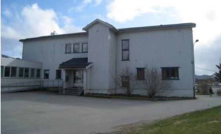
Bilde 1: Fasade mot nordøst
