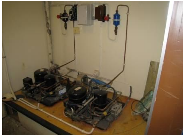
Bilde 43: Installasjon i kjølerom u.etg.
