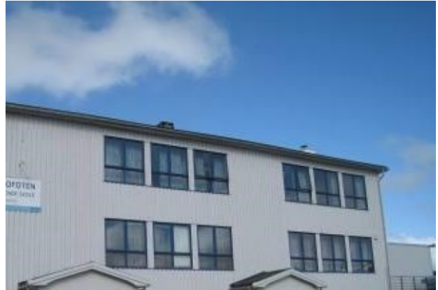
Bilde 50: Eksempelbilde, pipeløp på bygningen.
