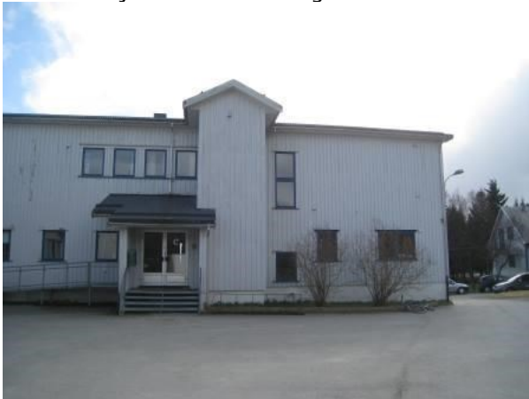
Bilde 46: Eksempelbilde. Asfalterte områder ved bygningen.
