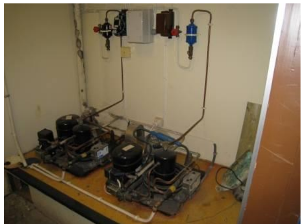
Bilde 41: Eksempelbilde EE-avfall. Fra kjølerom U.etg.
