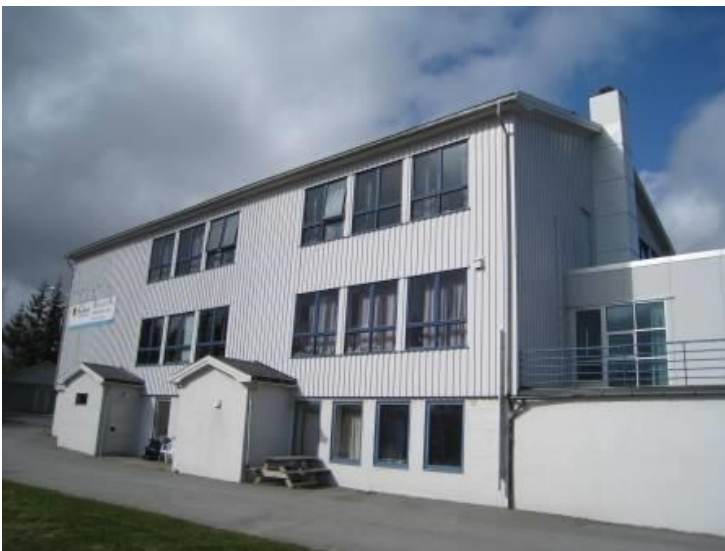
Bilde 3: Fasade mot sørøst
