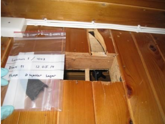
Bilde 51: Prøve 11 viser innhold av PAH klassifisert som farlig avfall.
