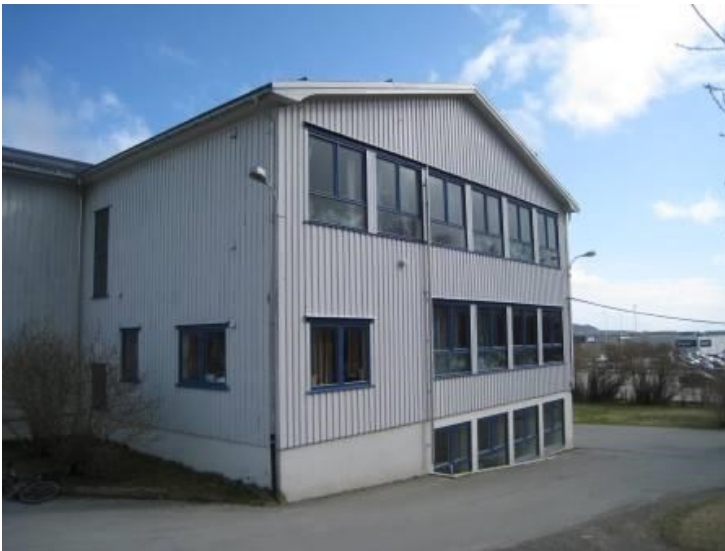
Bilde 2: Fasade mot nordvest
