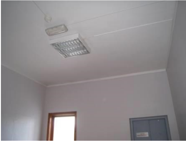
Bilde 36: Eksempelbilde EE-avfall. Fra trapperom 2.etg.
