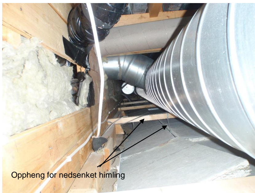
Bilde 4: Del B, 1. etasje. Areal over himling i korridor/rømningsvei.
