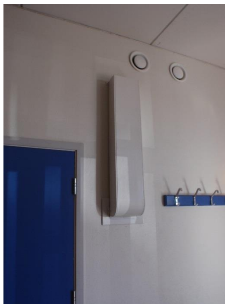
Bilde 11: Del C, underetasje. Åpen hull i vegg fra serverrom, sett fra trapperom.
