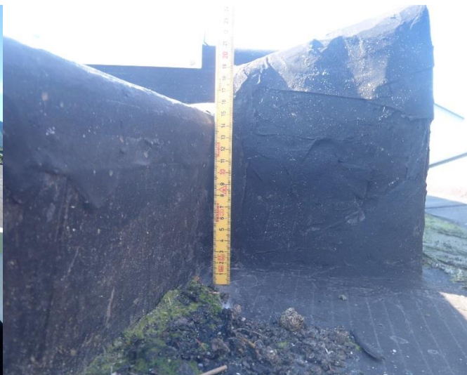
Bilde 17: Høyde på seksjoneringsvegg over tak.
