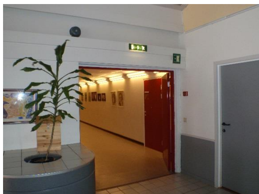
Bilde 12: 1. Etasje, detalj som viser dører i korridor i seksjoneringsvegg mellom del C og del B.
