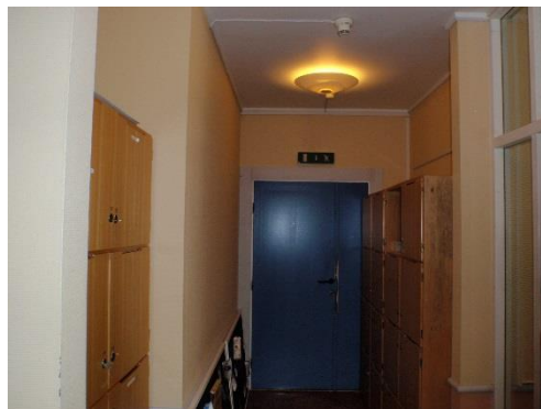
Bilde 15: 1. etasje, personalrom i del C, port/dør i seksjoneringsvegg til i klasserom i del B.
