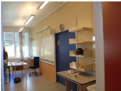
Bilde 14: 1. Etasje, port i seksjoneringsvegg i klasserom i del B.
