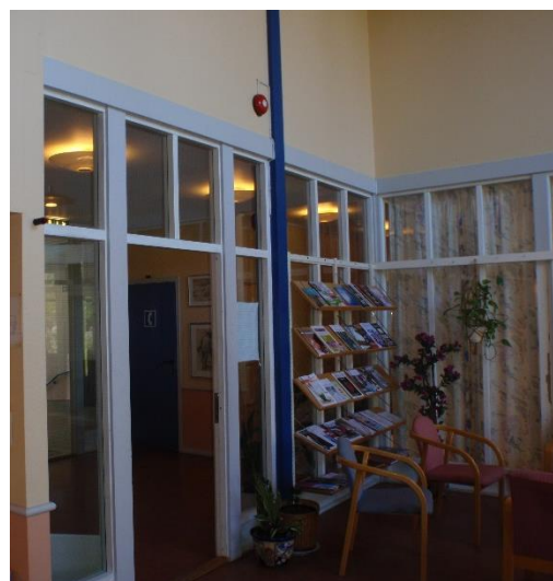
Bilde 7: Del C, 1. Etasje. Trådglass i vegg til personalrom.
