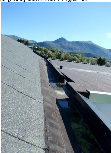
Bilde 16: 1. Deler av seksjoneringsvegg over tak fjernet.
