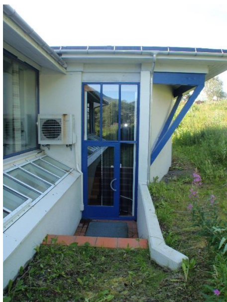
Bilde 8: Del C, 1. Etasje. Utvendig rømningsvei fra auditorium forbi overlysvinduer fra bibliotek.
