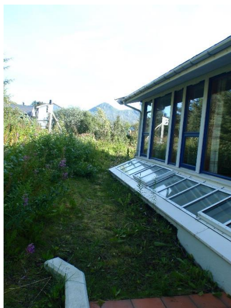
Bilde 9: Del C, 1. Etasje. Rømningsvei fra auditorium forbi vindu til klasserom og overlysvinduer til bibliotek i underetasje.
