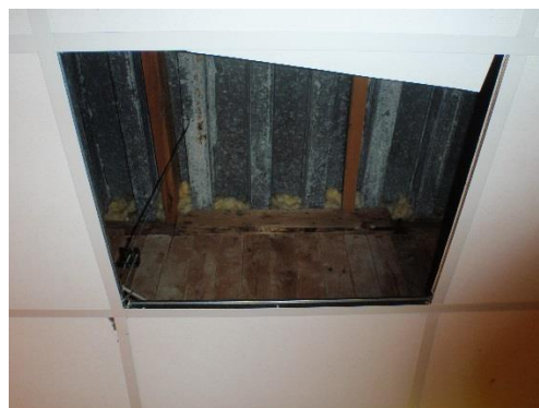
Bilde 3: Del B, over himling i underetasje.
