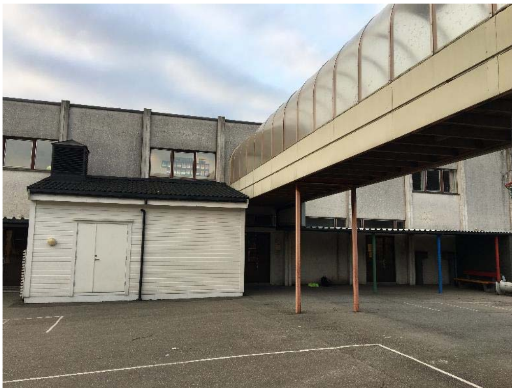
Bilde 3 - Gangbro som knytter sammen bygg A og B, og teknisk rom med nyere ventilasjonsanlegg.
