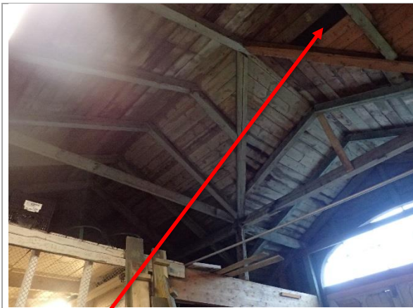
Bilde 1: Takpapp i yttertak i garasjeuthus
