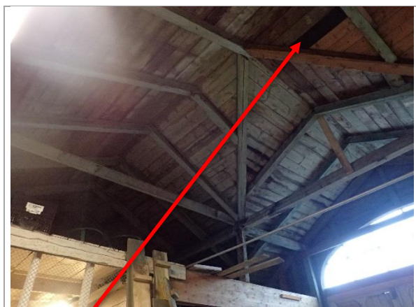
Bilde 15: Takpapp i yttertak i garasjeuthus.
