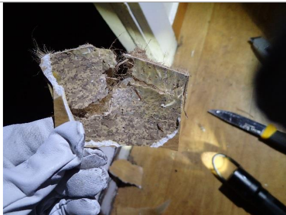
Bilde 11: Gulvbelegg i deler av 2. etasje.
