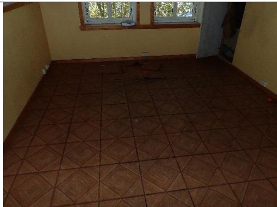
Bilde 13: Gulvbelegg i deler av 3. etasje.
