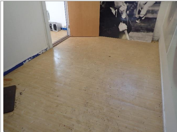
Bilde 9: Gulvbelegg i deler av 1. etasje.
