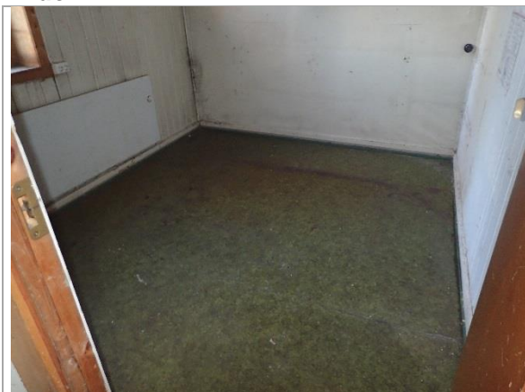
Bilde 7: Gulvbelegg i deler av 1. etasje.
