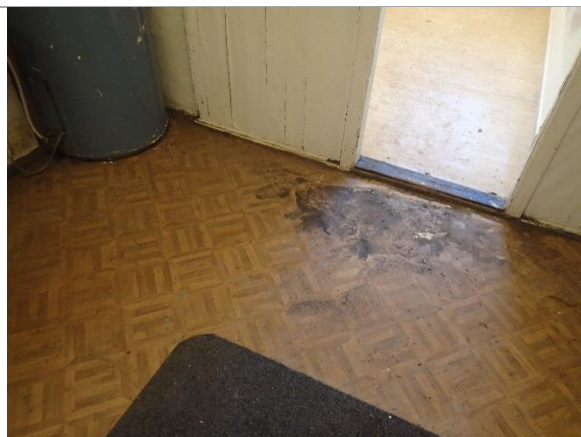
Bilde 8: Gulvbelegg på «kjøkken» i 1. etasje.
