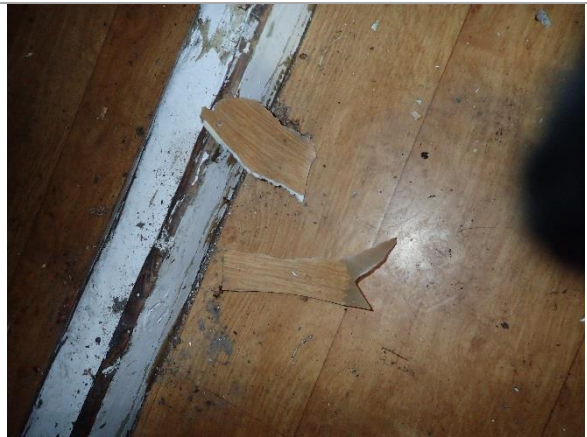
Bilde 10: Gulvbelegg deler av 2. etasje.
