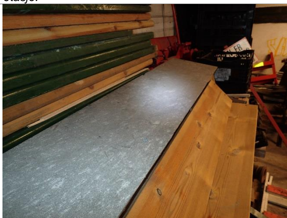
Bilde 4: Eternitplate i garasjeuthuset.
