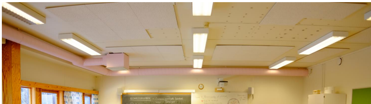
Klasserom med malt himling, og flåtehimling
