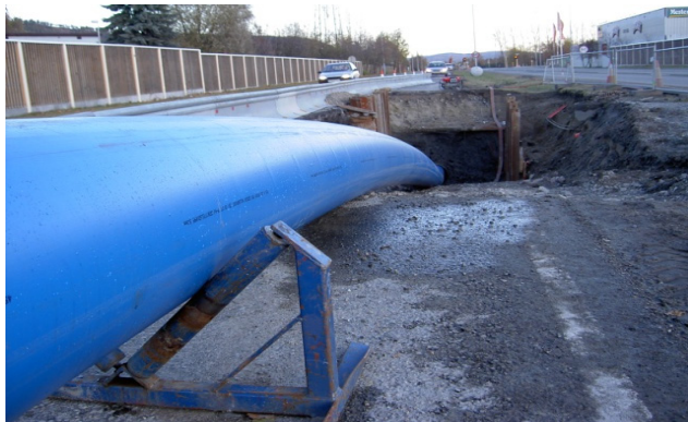
Bilde 6: PE-røret beskyttes mot ytre skader.
